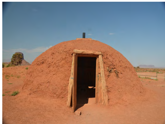
Foto 10. Hogans. Habitação sagrada dos Navajos construída com troncos de madeira e barro. Foto: Wagner Magalhães (Ago/2012).
