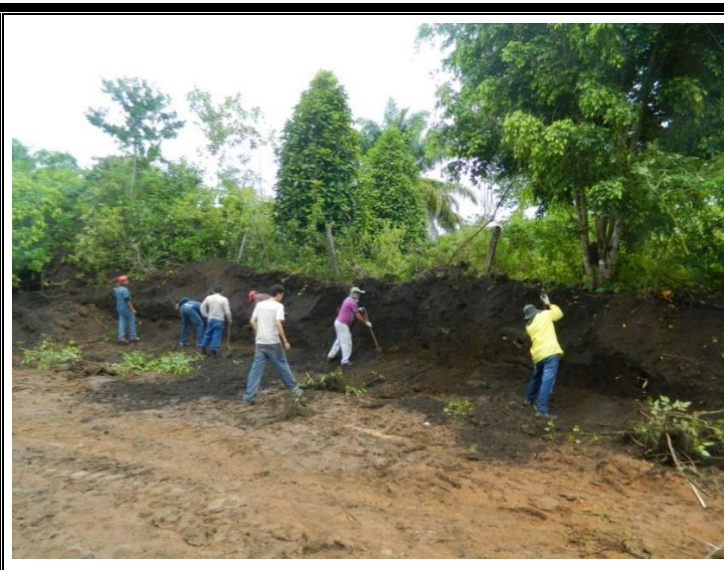
Figura 64: Abertura do Perfil Leste da Linha E9987(G.M.)
