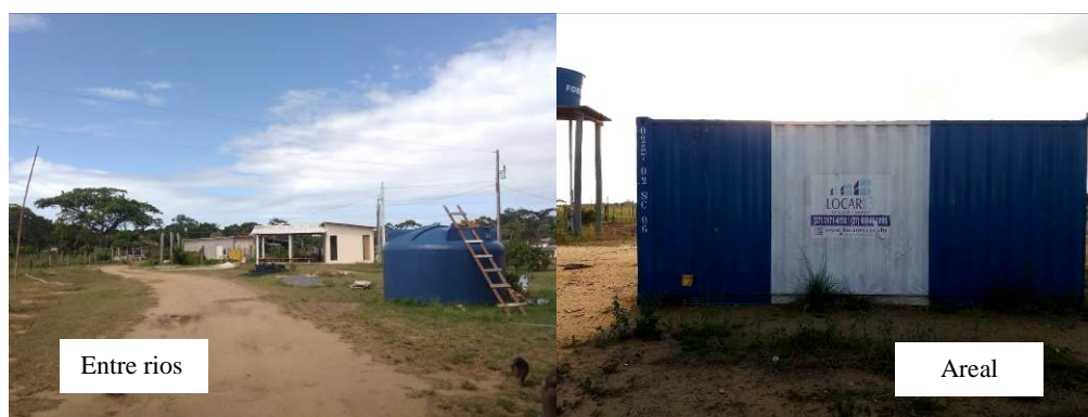
Figura 12. Tanque de armazenamento de água de beber em Entre Rios e Areal.
