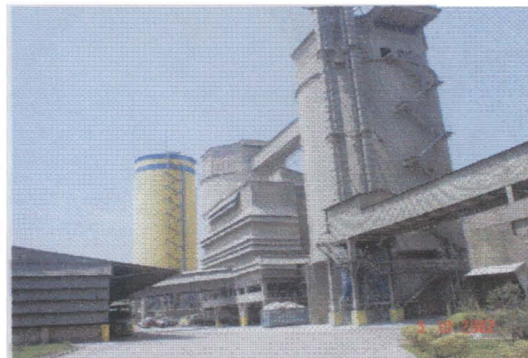
Figura 40- Silo de armazenamento
