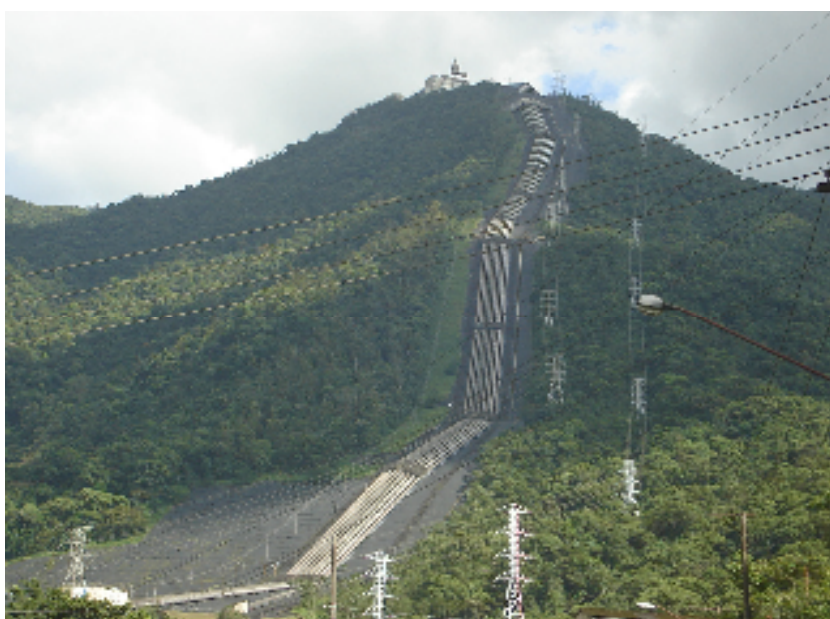
Figura 16: Adutoras da Usina Henry Borden, Cubatão. Fonte: a Autora 2006
