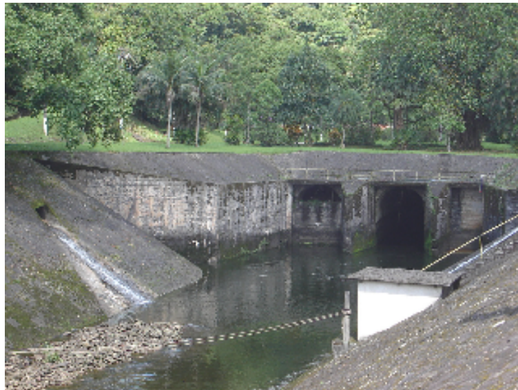
Figura 19: Saída de água da usina subterrânea. Fonte: a Autora 2006.
