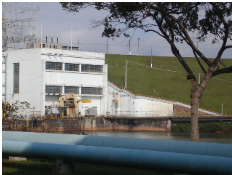
Figura 22: Usina Elevatória de Pedreira, Zona Sul de São Paulo. Fonte: a Autora 2006.
