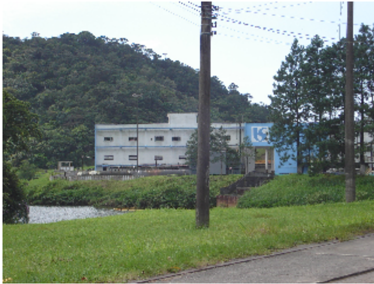
Figura 20: Estação de tratamento de água próxima à usina Henry Borden. Fonte: a Autora 2006.
