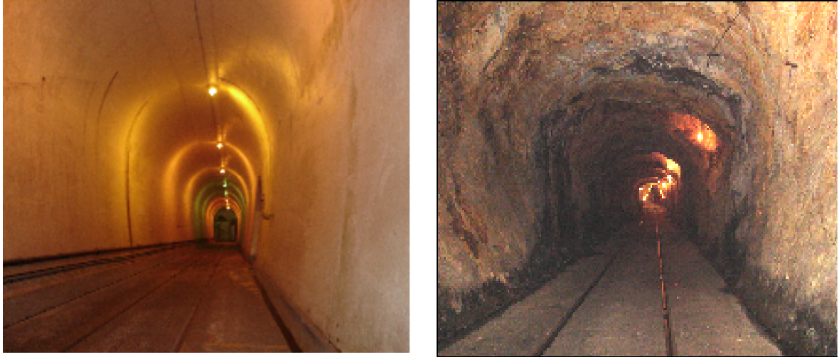
Figura 17: Entrada da Usina Subterrânea construída na rocha, sob a Serra do Mar. Fonte: a Autora 2006.
