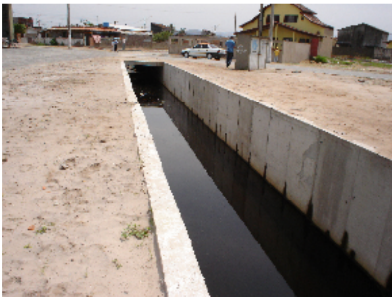
Figura 26: Canal de águas pluviais no município de Mongaguá. Fonte: arquivos CRHi 2005.
