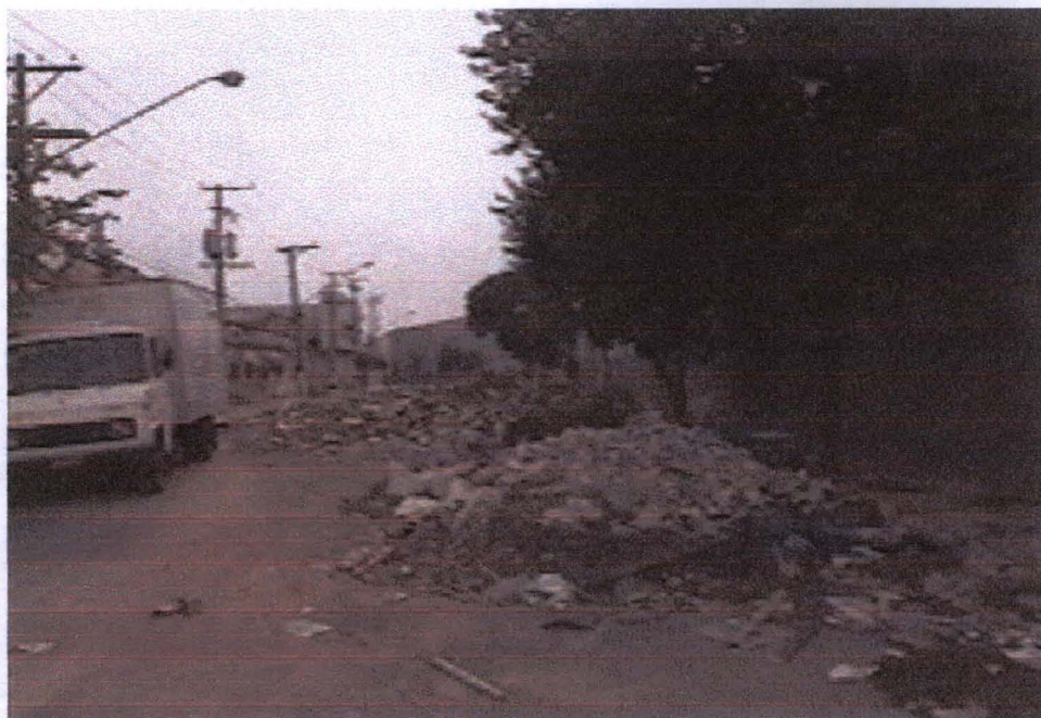
Figura 4.1.3 – Comprometimento de tráfego de veículos pela deposição irregular de RCD no município de São Paulo
