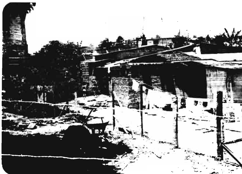
FIGURA 5 - Área externa das casas, tipo de construção
