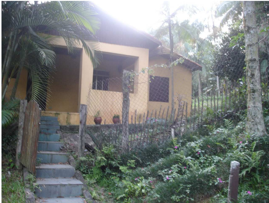
Figura 11. Peridomicílio da residência onde foram instaladas as armadilhas de Shannon branca e preta - PEC
