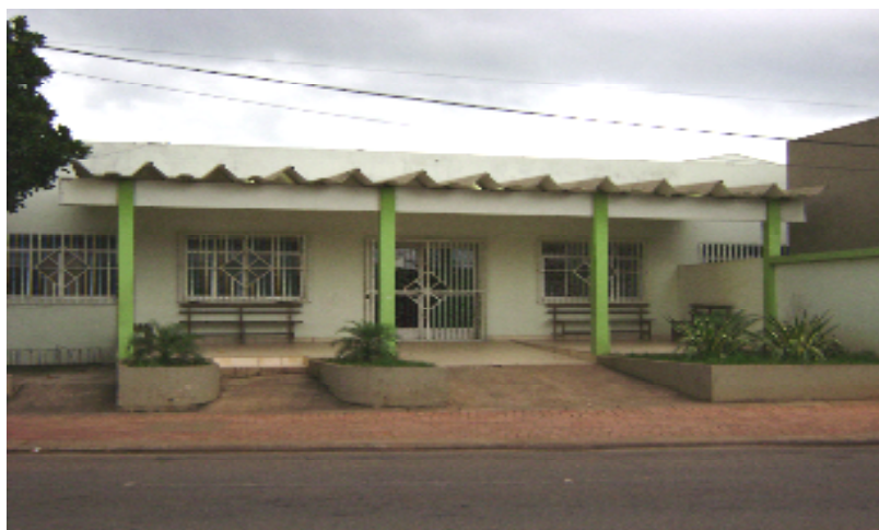
Figura 8 – Vista frontal do prédio do Serviço de Assistência Especializada – SAE.
