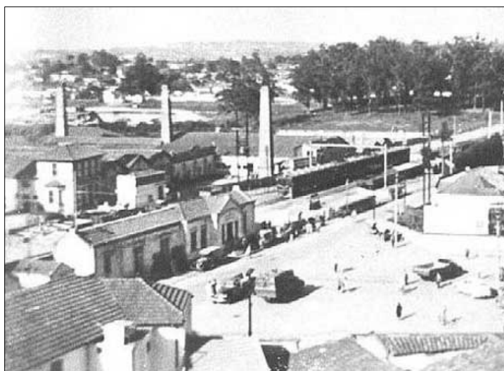
Foto 4 - Largo de Osasco, anos 1940: primeira estação, que fora construída por Antônio Agu, e, ao fundo, a Cerâmica Industrial Osasco
