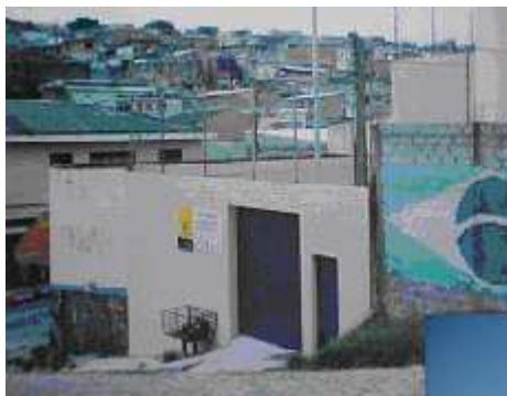
Figura 5 – Fachada do prédio inicial do CEI pesquisado
