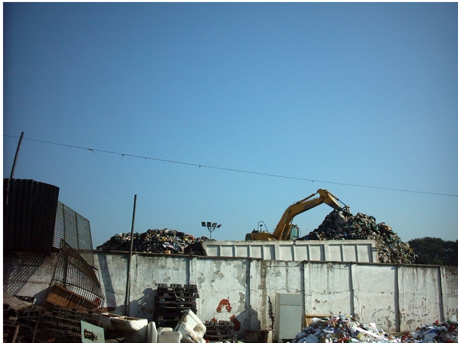
Muro que dividia o pátio da cooperativa e a central de transbordo da Loga (ao fundo).
