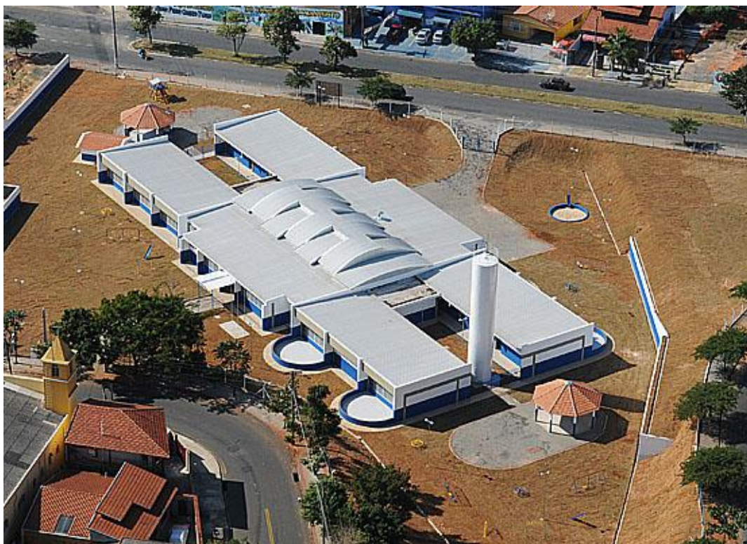
Figura 3 - Vista aérea da “Nave-Mãe”
