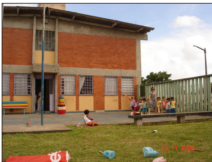
Figura 1- Entrada do prédio principal do CEI
