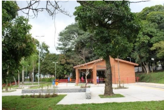
Figura 7: Vista do Parque Lajeado.
