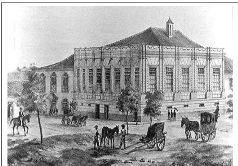
Figura 35 – Palácio Conde dos Arcos (1819). Atualmente é sede da Faculdade de Direito da Universidade Federal do Rio de Janeiro (1920). Fonte: www.wikipedia.org
