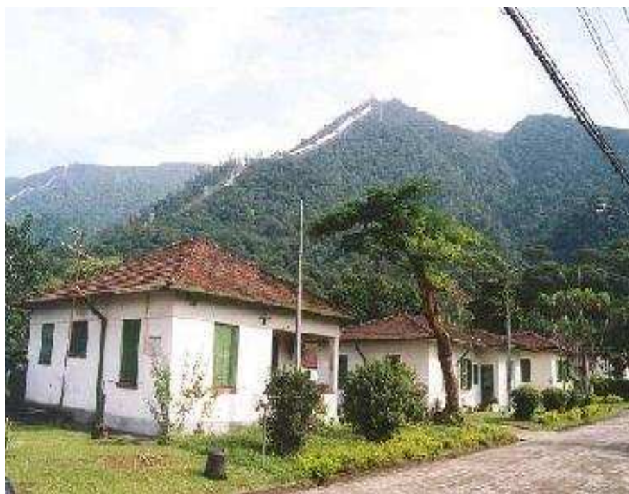
Figura 25 – Portaria de acesso à Vila Light (ao final da rua localiza-se a UME Usina Henry Borden). Na fotografia à direita, visão de algumas residências da vila residencial em seu estilo arquitetônico característico de início do século XX.
