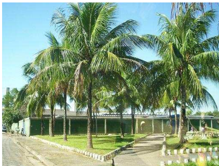
Figura 13 – Visão frontal da UME Martim Afonso de Souza (prédio verde, atrás dos coqueiros).
