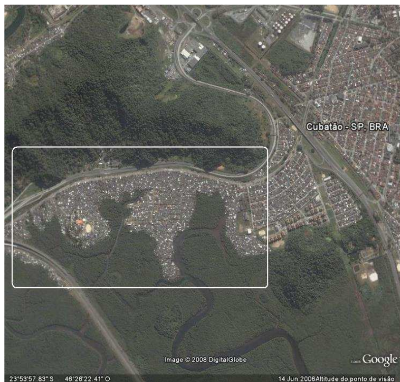
Figura 29 – Vista aérea de região de manguezal altamente antropizada por invasões de assentamentos irregulares e palafitas (no interior do retângulo branco, concentração de residências em área invadida de manguezal). Esta comunidade é conhecida como Vila Esperança.
