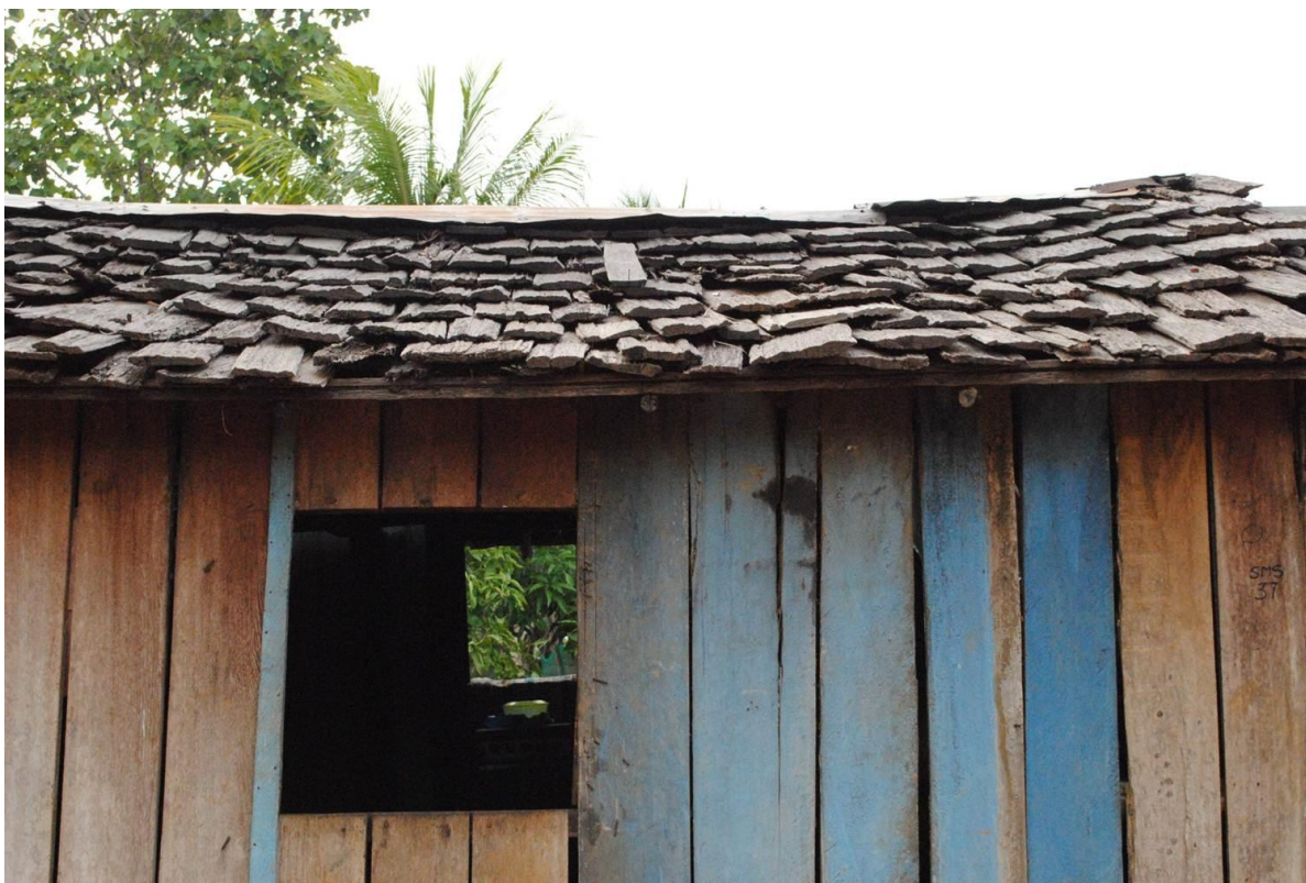
Foto 22: Última casa do assentamento com telhado de madeira.
