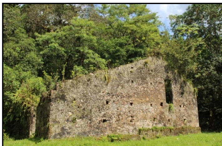
Figura 63 - Ruínas da Antiga Construção
