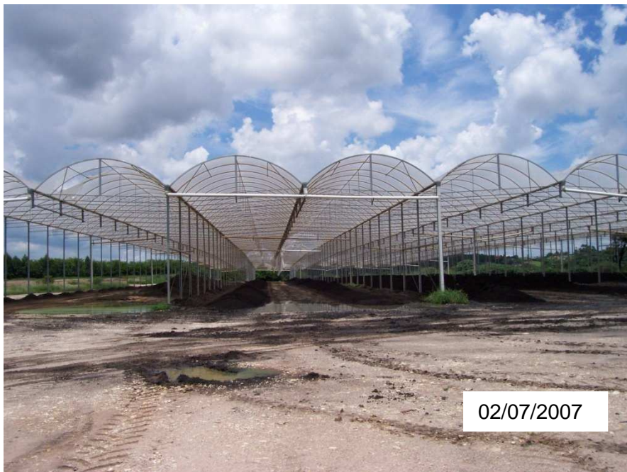
Figura 7: Leiras de secagem onde são levados os lodos após passarem pelo processo de desaguamento feito em centrífugas na ETE de Jundiaí.
