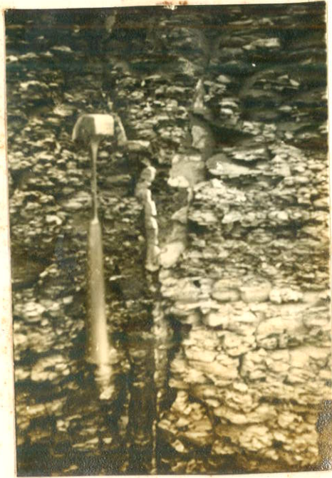
Foto nº 35 - Detalhe da foto nº 34.
