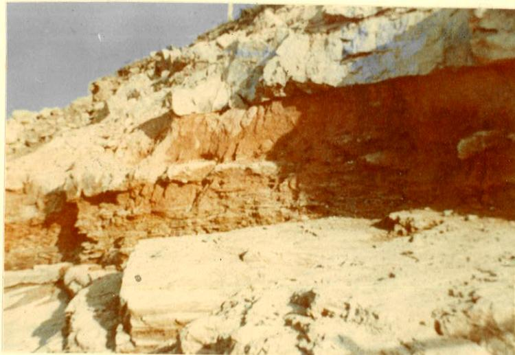
FIG. 1.3 - Ocorrência de camada alterada em gnaisses - nas escavações da barragem de Vargem das Flores, M.G. ( foto gentilmente cedida pelo Engº J.E.S. Silveira )
