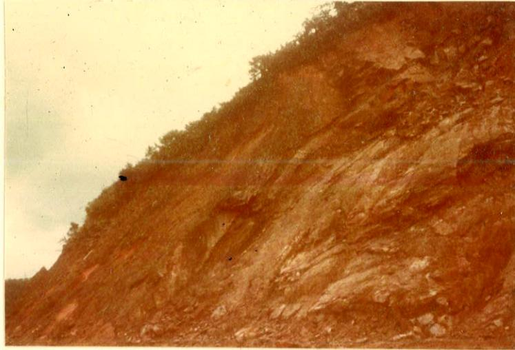
FIG. 1.2 - Escorregamentos provocados por camadas alteradas, em gnaisses, em corte da rodovia Piaçaguera-Guarujá, S.P. ( foto gentilmente cedida pelo Geólº A. - Ribeiro Jr. )
