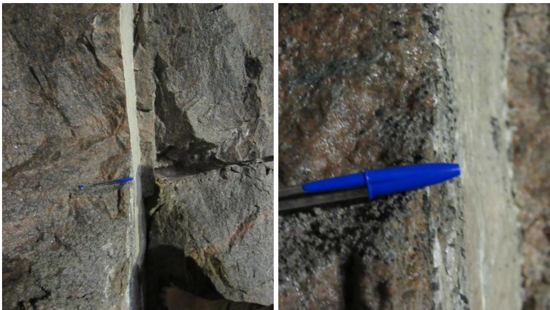
Figura 47 – Calcita e argilominerais preenchendo plano de fratura interceptado pelo túnel. O material reagiu quando em contato com ácido clorídrico.
