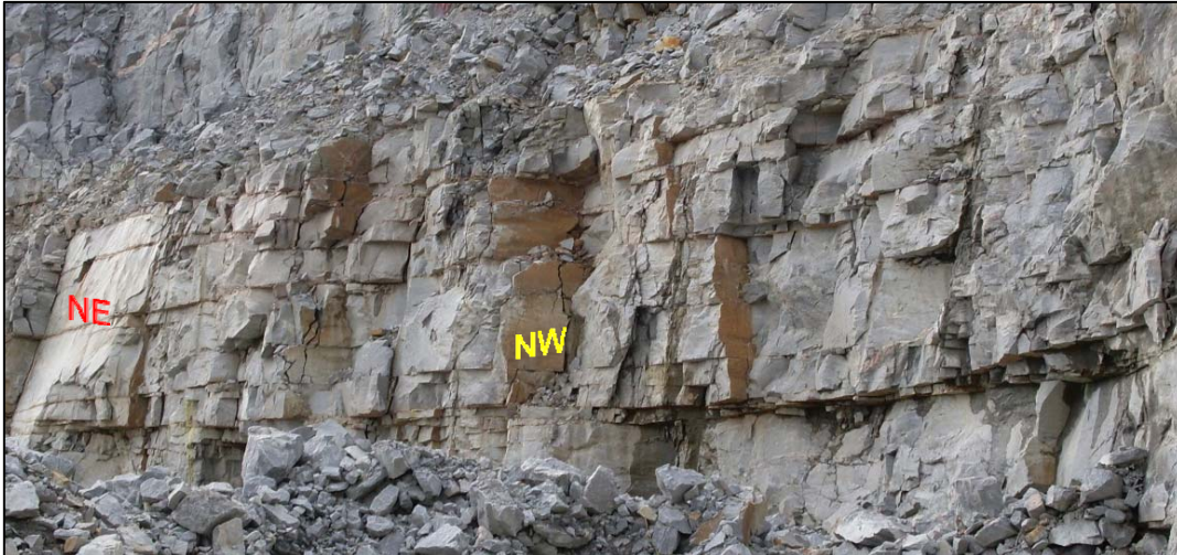
Figura 50 - GS-1, próximo ao ponto B: fraturas de direção NW subverticais terminam nas fraturas de baixo ângulo da GS-1, indicando que as fraturas NW são mais jovens (notar alteração ocre das fraturas NW, e fratura NE de alto ângulo, no canto esquerdo da foto, quase sem alteração)
