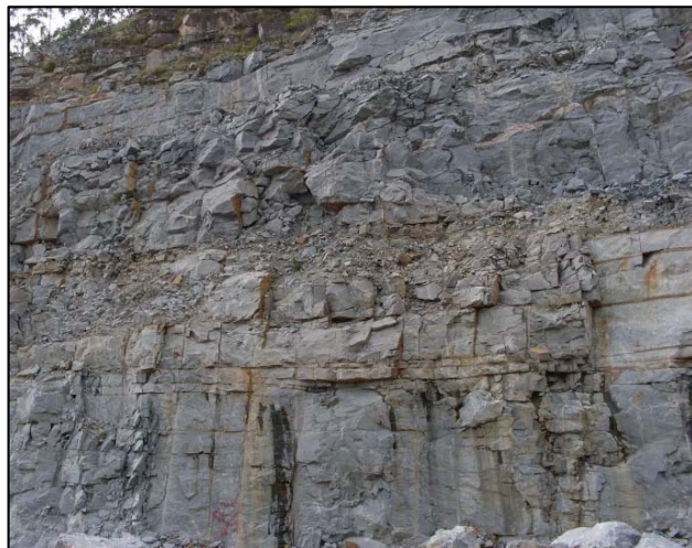
Figura 43 - GS-1, ponto B: observam-se fraturas de sub-horizontais com alteração evidente (cor ocre) na porção central da foto, e fraturas NW quase ortogonais à parede, terminando nas fraturas sub-horizontais; acima e abaixo da faixa com fraturas sub-horizontais de cor ocre, a rocha apresenta-se menos alterada
