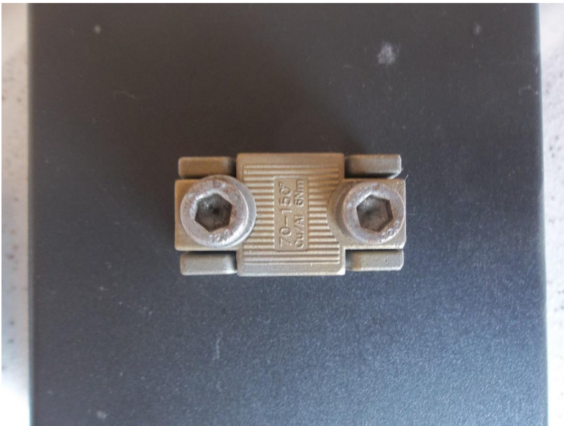
Figura 6 – Sensor (unidade escravo) conexão ao eletrodo.
