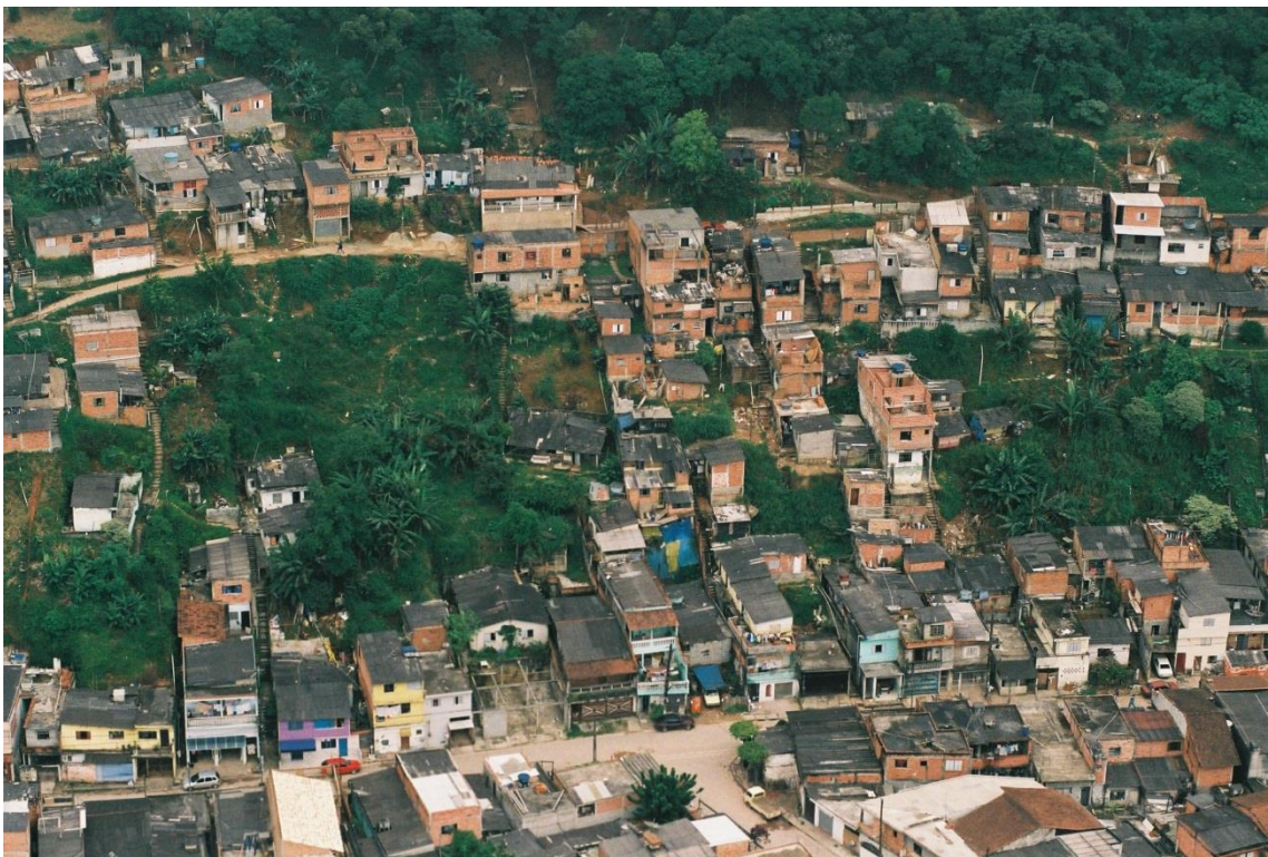
Foto 4.1: Visão geral de encosta localizada no bairro Areião, ocupação na base e no topo de encosta natural com diversas intervenções de corte e aterro. A parte central da foto mostra ainda ocupação a meia encosta. (São Bernardo do Campo, 2010b).
