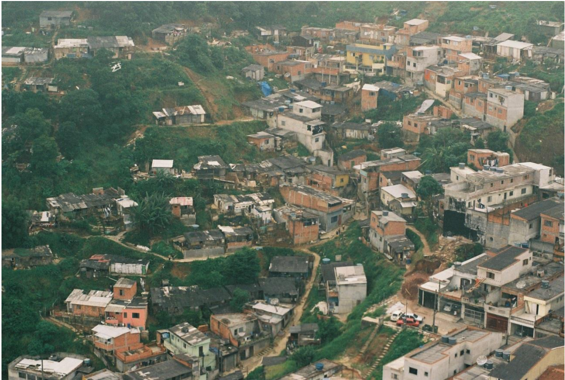
Foto 4.2: Encosta localizada no bairro Vila São José, ocupação em toda a encosta natural com diversas intervenções de corte e aterro. Terreno formando um vale com curvatura côncava. (São Bernardo do Campo, 2010b).
