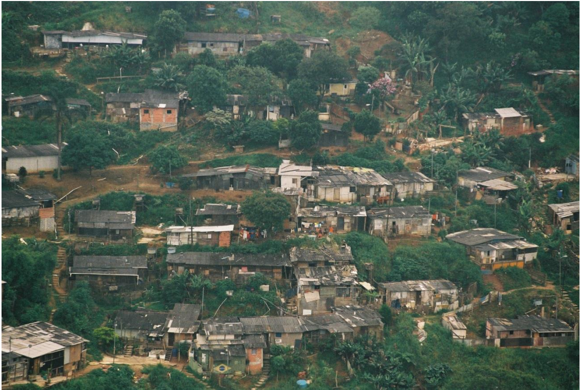
Foto 4.4: Encosta localizada no bairro Jardim Silvina, moradias com baixo padrão construtivo, instaladas após a intervenção do tipo corte e aterro. (São Bernardo do Campo, 2010b).
