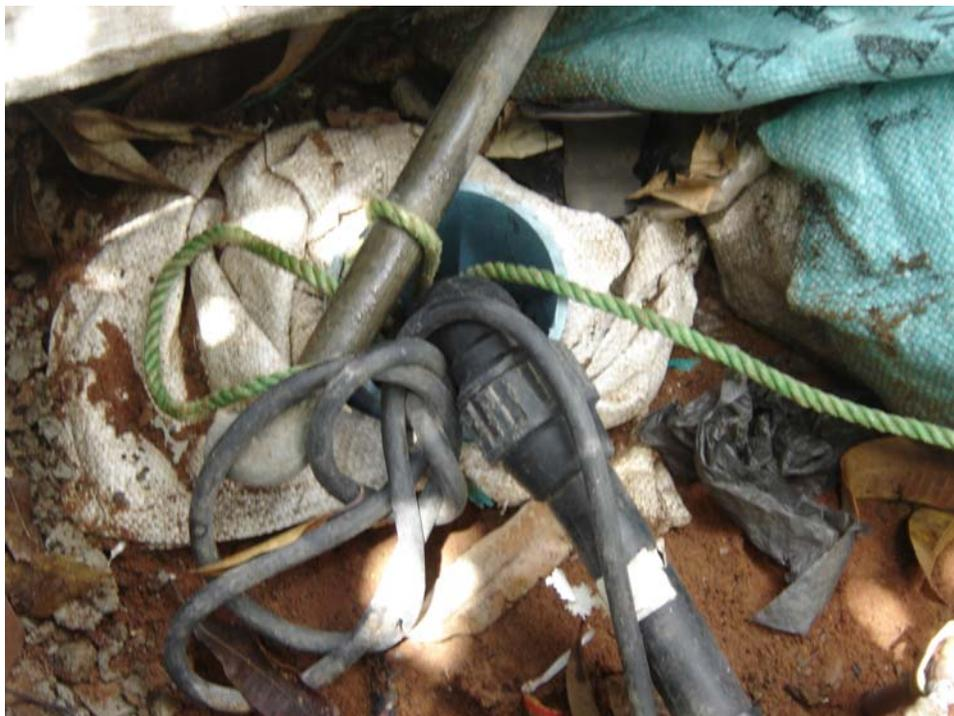
**FOTO 4- Poço sem cimentação, laje e tampa de proteção. Observa-se a saliência o tubo de revestimento está ao nível do solo e com o acúmulo de lixo ao redor dele.**
