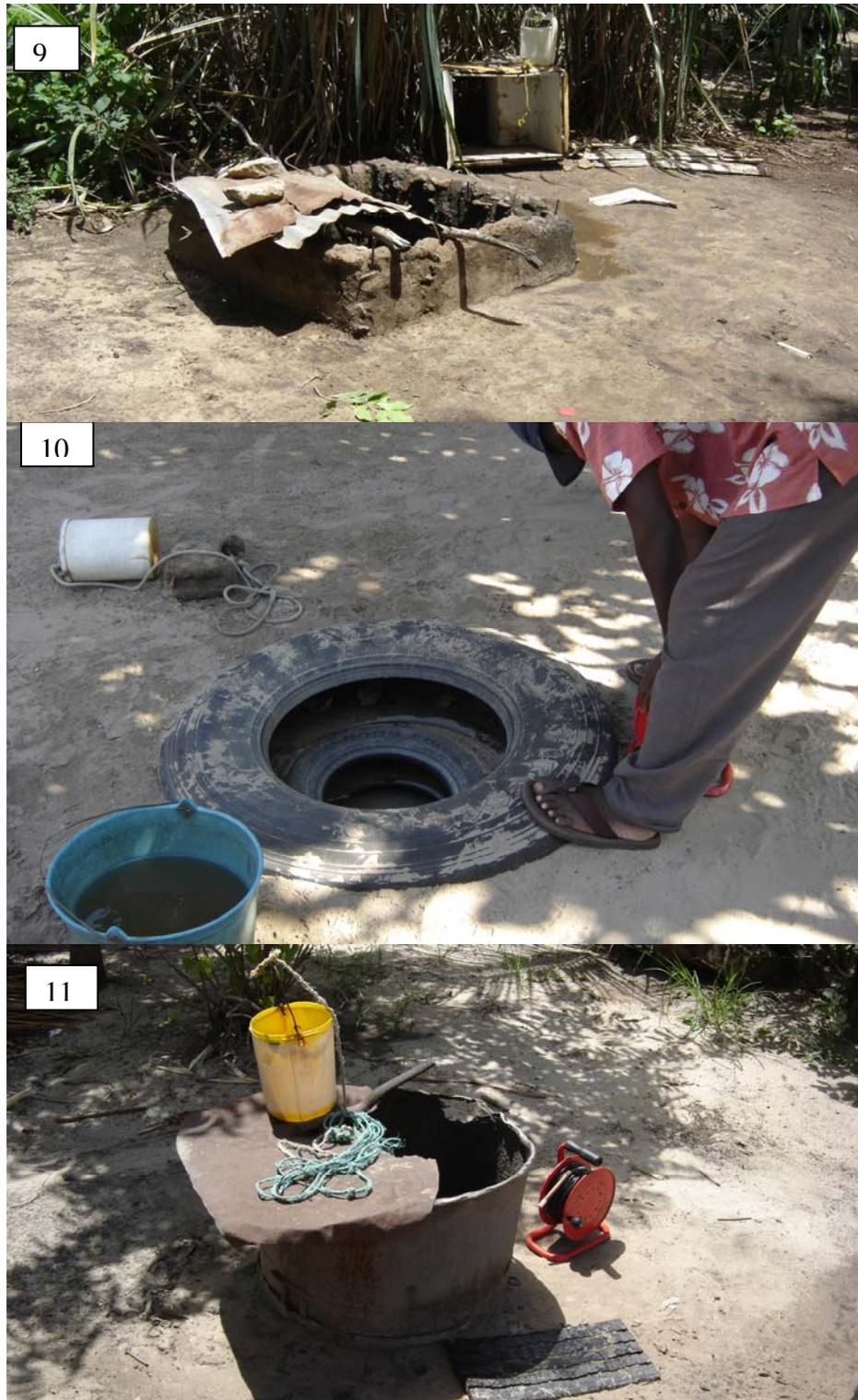
**FOTOS 9,10 e 11- Poços rasos revestidos de material não adequado e sem o mínimo e estrutura de proteção.**
