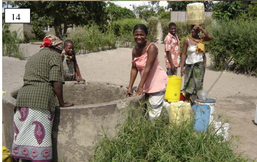
**FOTOS 13 e 14- Fotos ilustrando uma situação em que falta de tampa do poço potenciam a contaminação direta da água subterrânea. Várias pessoas introduzem no poço ao mesmo tempo o sistema balde-corda sobre condições de higiene precárias.**
