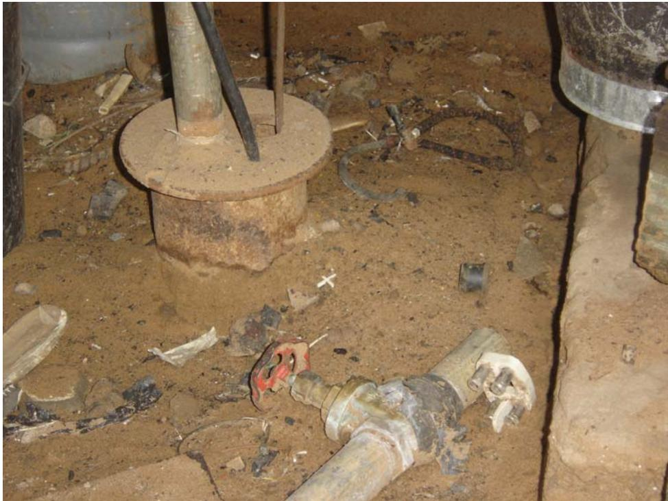
**FOTO 3- Exemplo de um poço sem selo e laje sanitária.**
