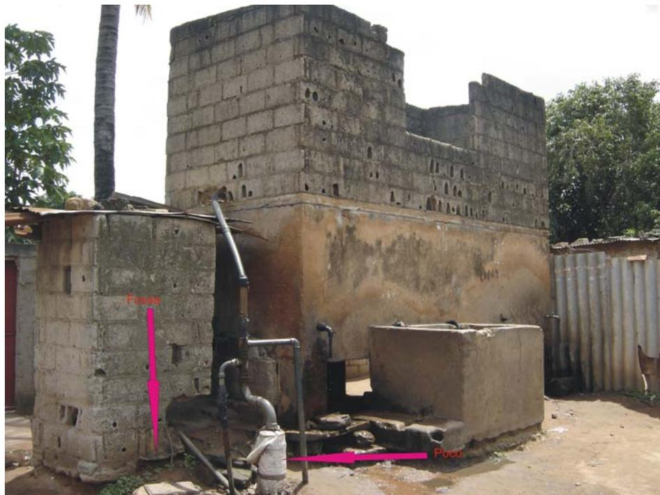
**FOTO 1- Poço instalado junto de uma fossa séptica.**
