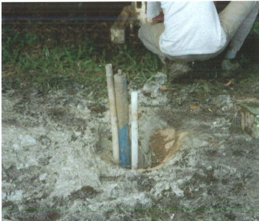
Figura 11: Conjunto multinível recém-instalado.
