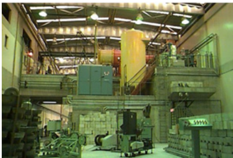
Figura 4-7 Acelerador Industrial de Elétrons fabricado pela RDI, modelo JOB 307, energia de 1,5 MeV e potência de 97,5 kW.
