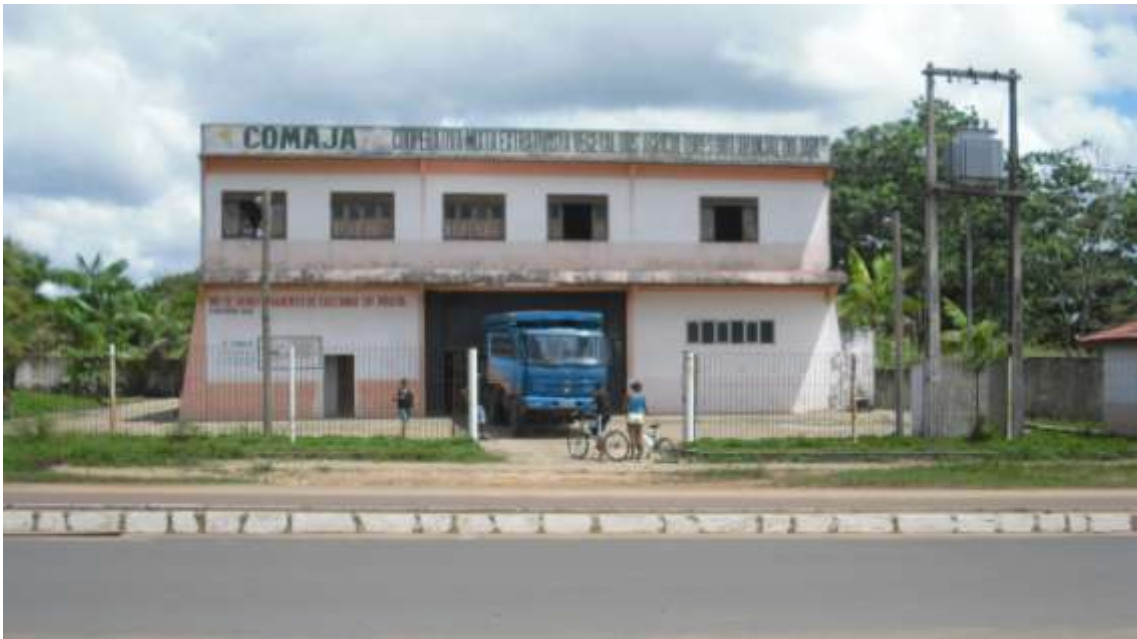
Figura 32 – Fachada da COMAJA
