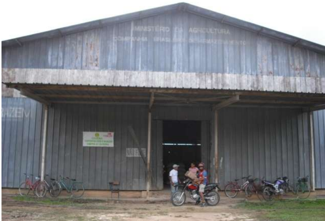
Figura 21 – Fachada da COVEMA
