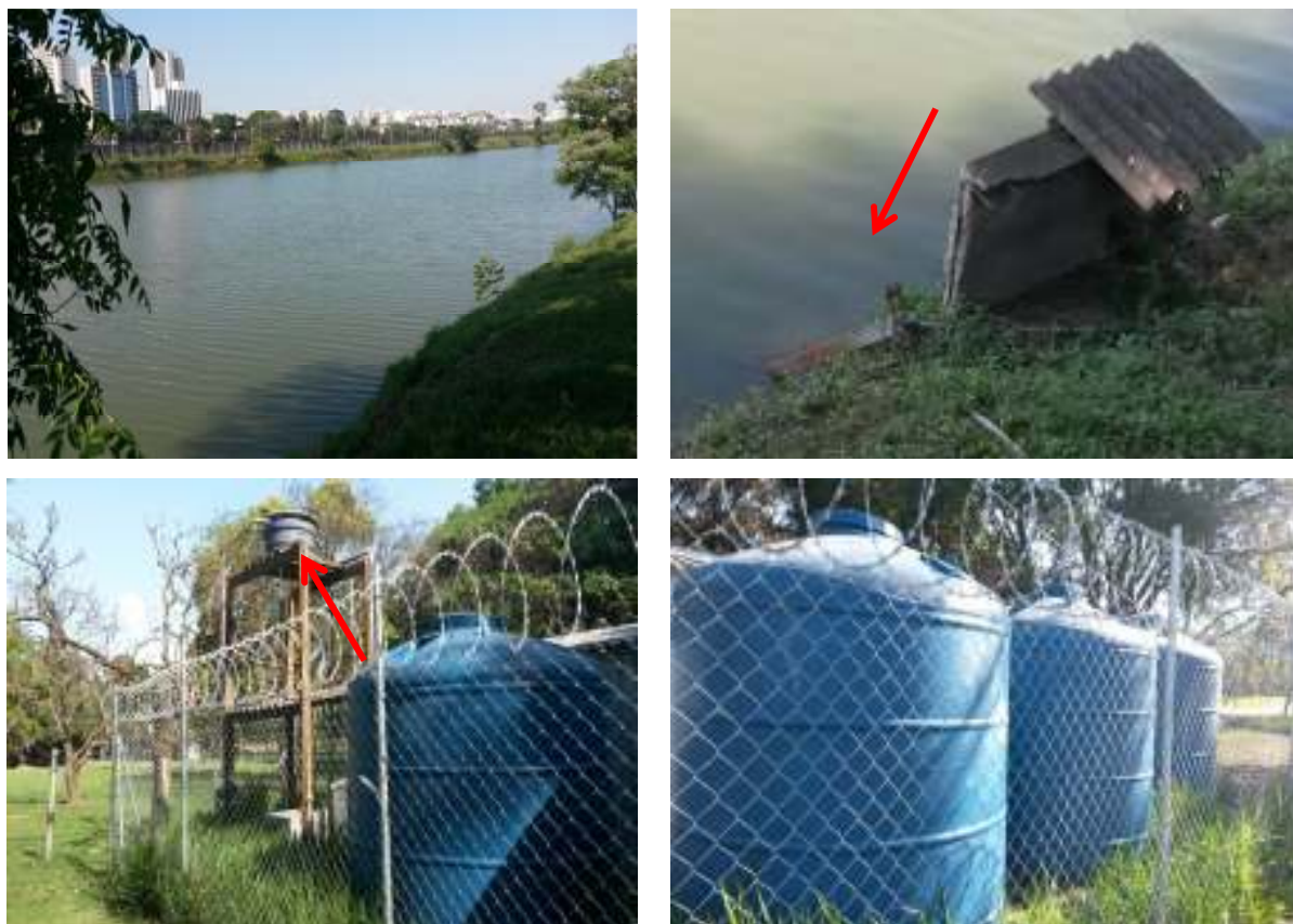
Figura 63 – Filtros lentos de areia montados no “Container” da Raia Olímpica da USP, SP. a) Raia Olímpica da USP; b) Bomba de captação da água da Raia Olímpica da USP; c) Reservatório que alimenta os filtros lentos de areia; d) filtros lentos de areia.
