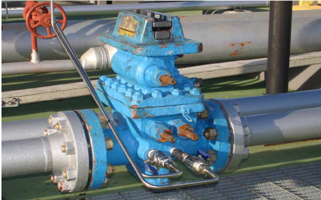
Figura 5.7: Válvula porta-placa usada nos experimentos.
