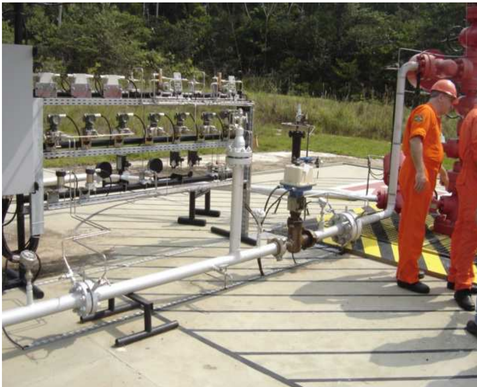
Figura 6.2: Montagem dos medidores diferenciais de pressão na linha de produção.
