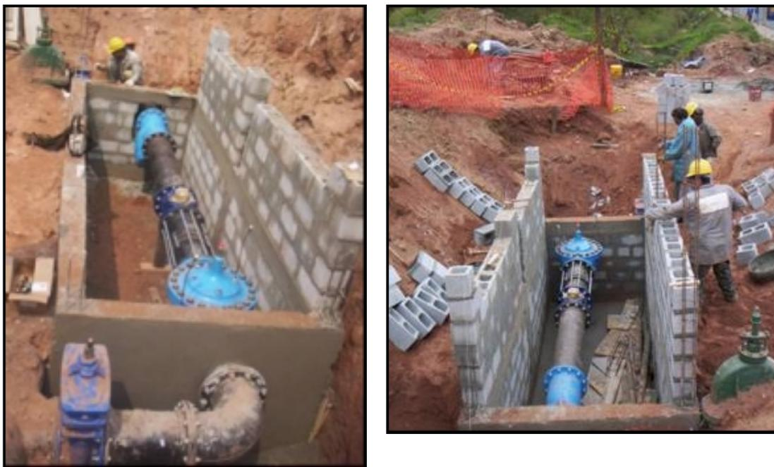
Figura 19 – Obra de implantação de subsetor controlado por VRP.
