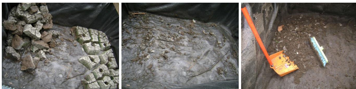
Figura 54 - Retirada da torta e limpeza da manta geotêxtil
