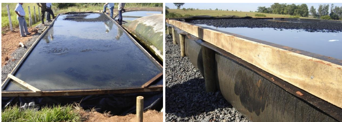
Figura 82 - Sugestão construtiva para leitos de drenagem como forma de aumentar a exposição da manta geotêxtil ao ar (Fontana, 2008)
