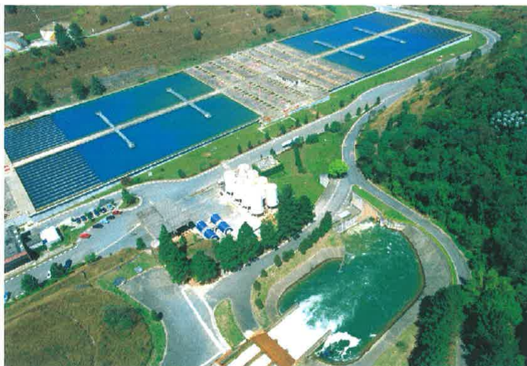
Figura 4.2 – Vista da ETA Guarauá
