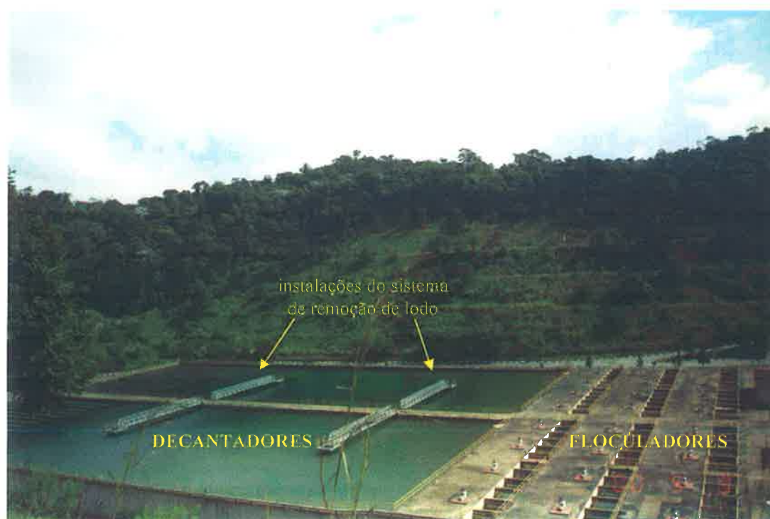
Figura 4.4 – ETA Guaraú: Vista dos Decantadores e Floculadores
