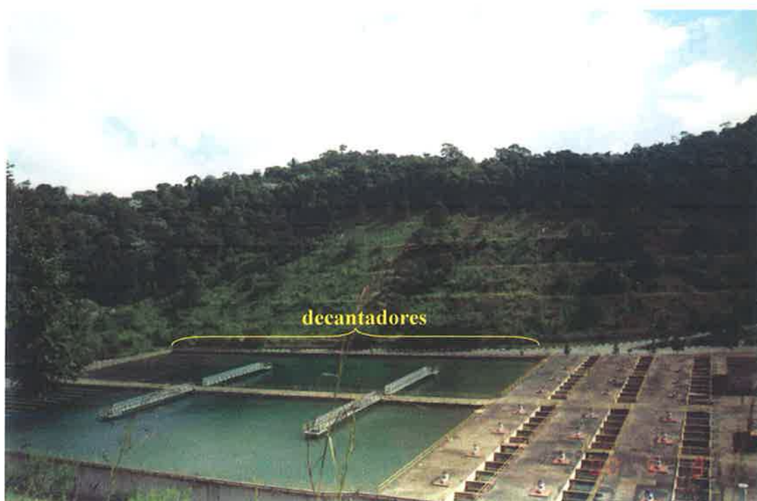
Figura 3.3 – Decantadores na ETA Guarau
