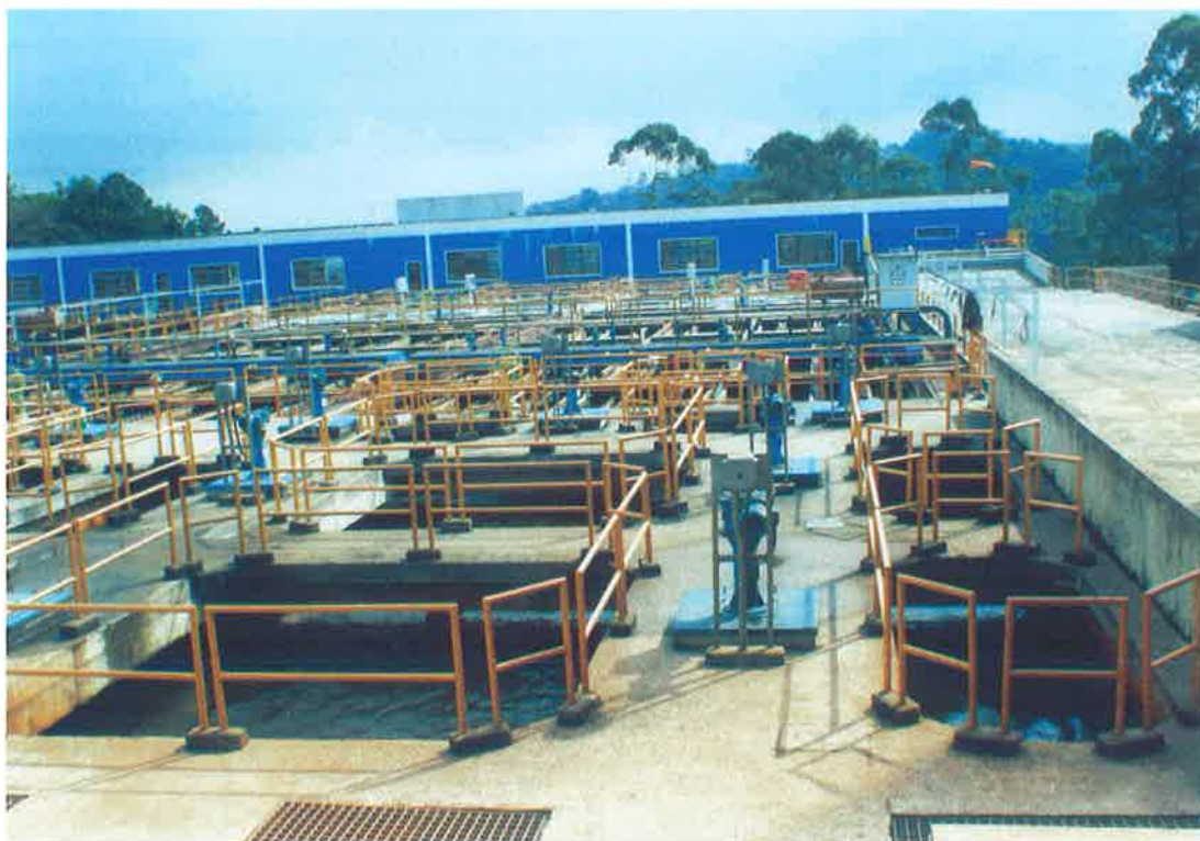
Figura 4.3 – Vista da ETA Rio Grande
