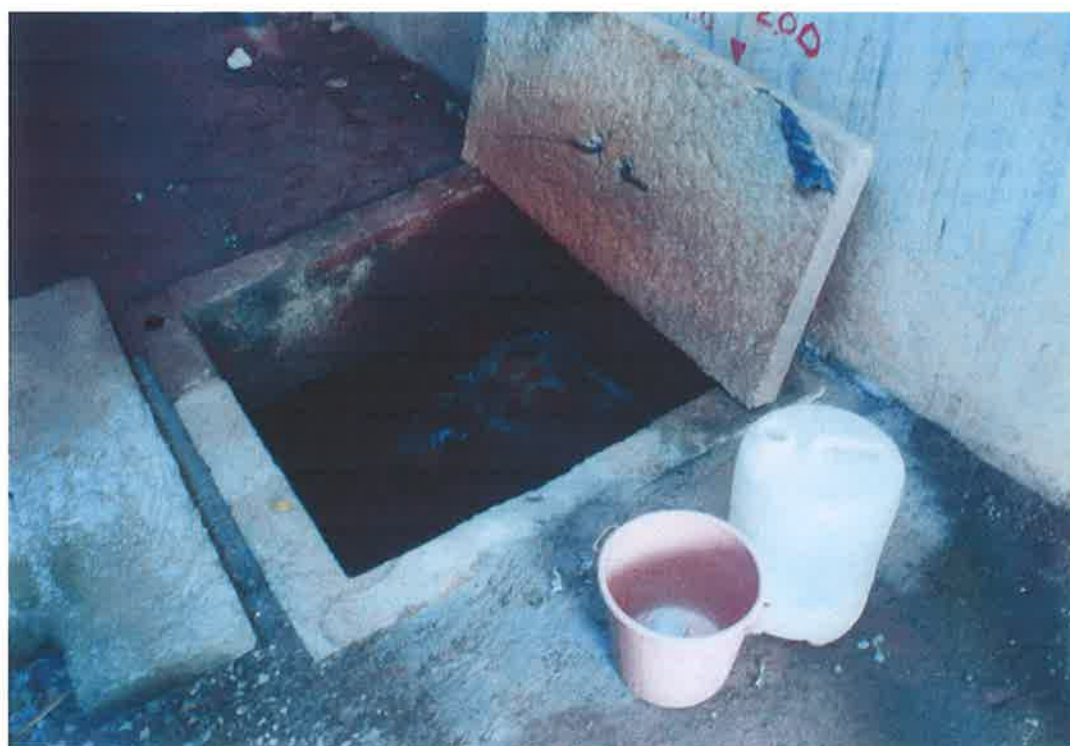
Figura 4.7 – ETA Rio Grande: Ponto de Coleta de Lodo
