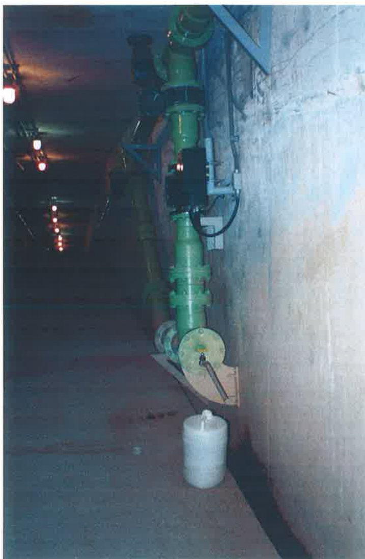
Figura 4.5 – ETA Guaraú: Local de Coleta de Lodo
