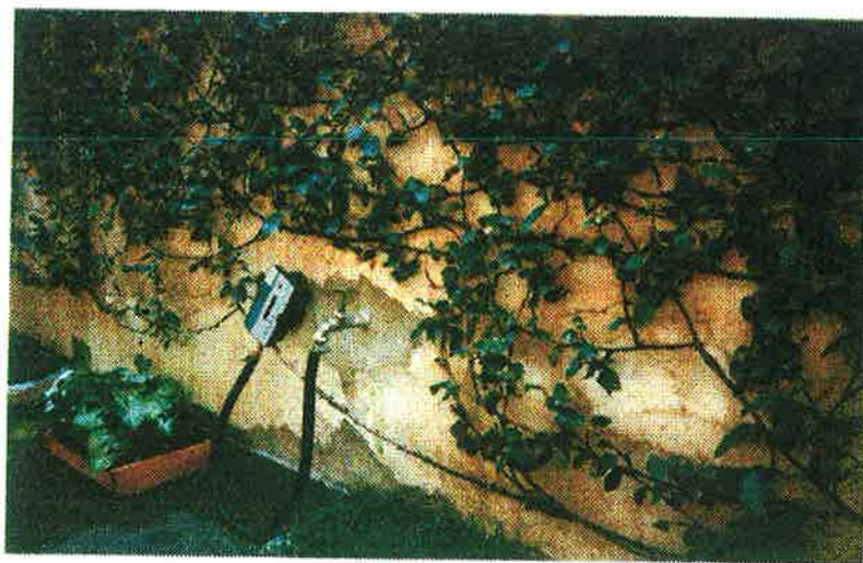
Figura 5.4 – Monitoração da pressão hidráulica no alimentador predial de um edifício residencial unifamiliar.
