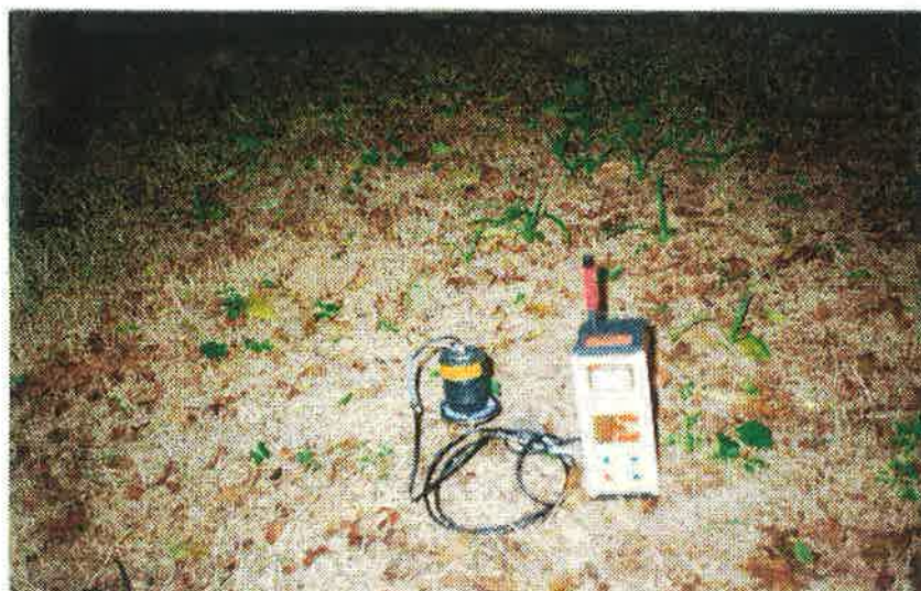
Figura 6.48 – Instalação do pré-amplificador vermelho e sensor sobre o registro de gaveta do trecho pesquisado.
