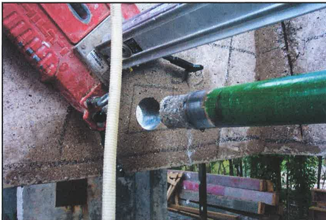
Figura 3-9 – Detalhe da extração de testemunhos.
