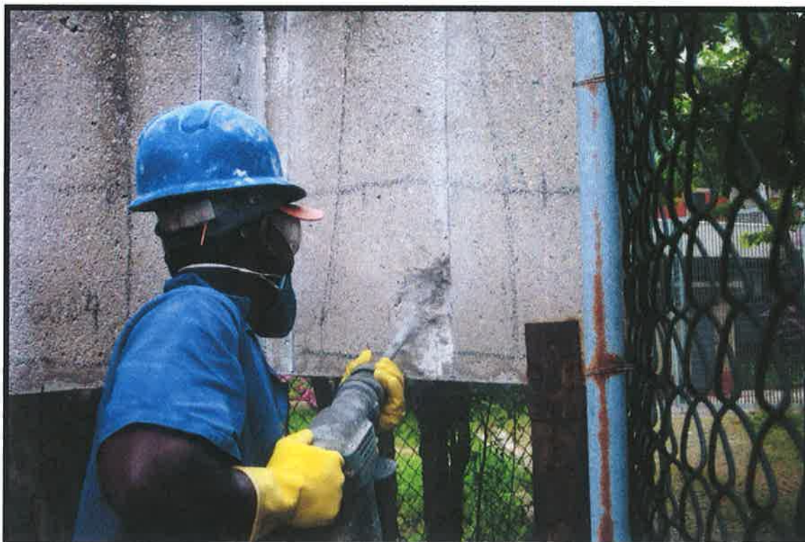
Figura A-5 – Remoção do concreto deteriorado.
