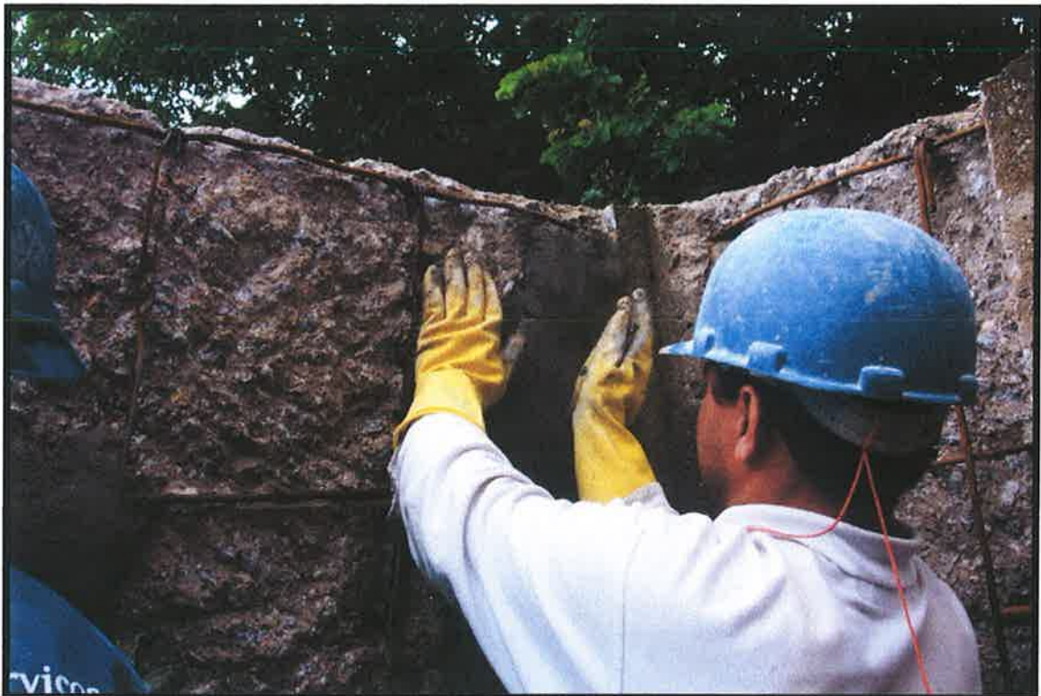
Figura A-10 – Aplicação da argamassa de reparo com as mãos.
