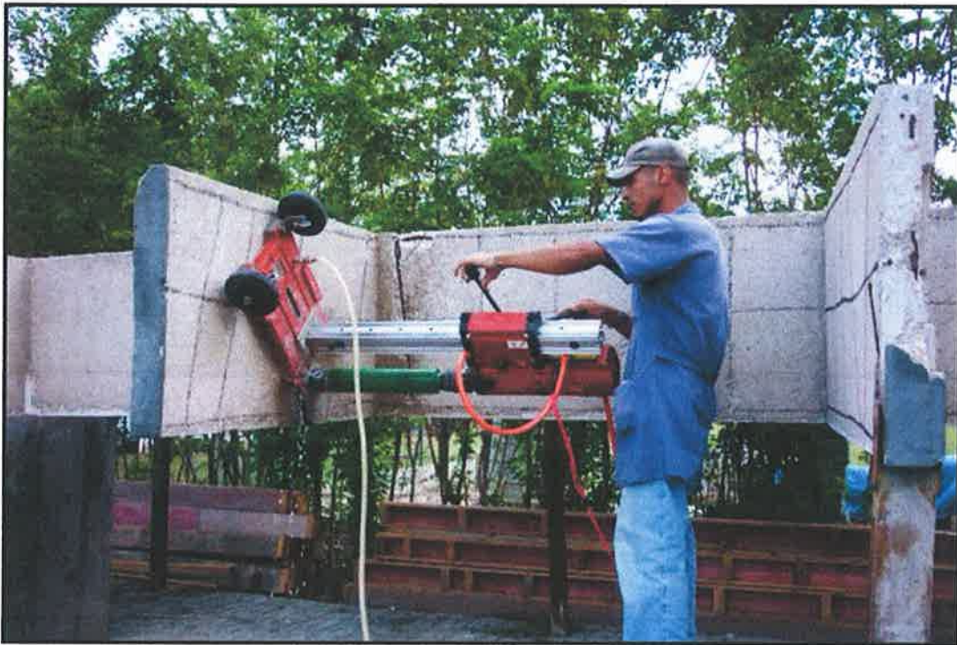
Figura 3-8 – Extração de testemunhos para caracterização das propriedades do protótipo estrutural.
