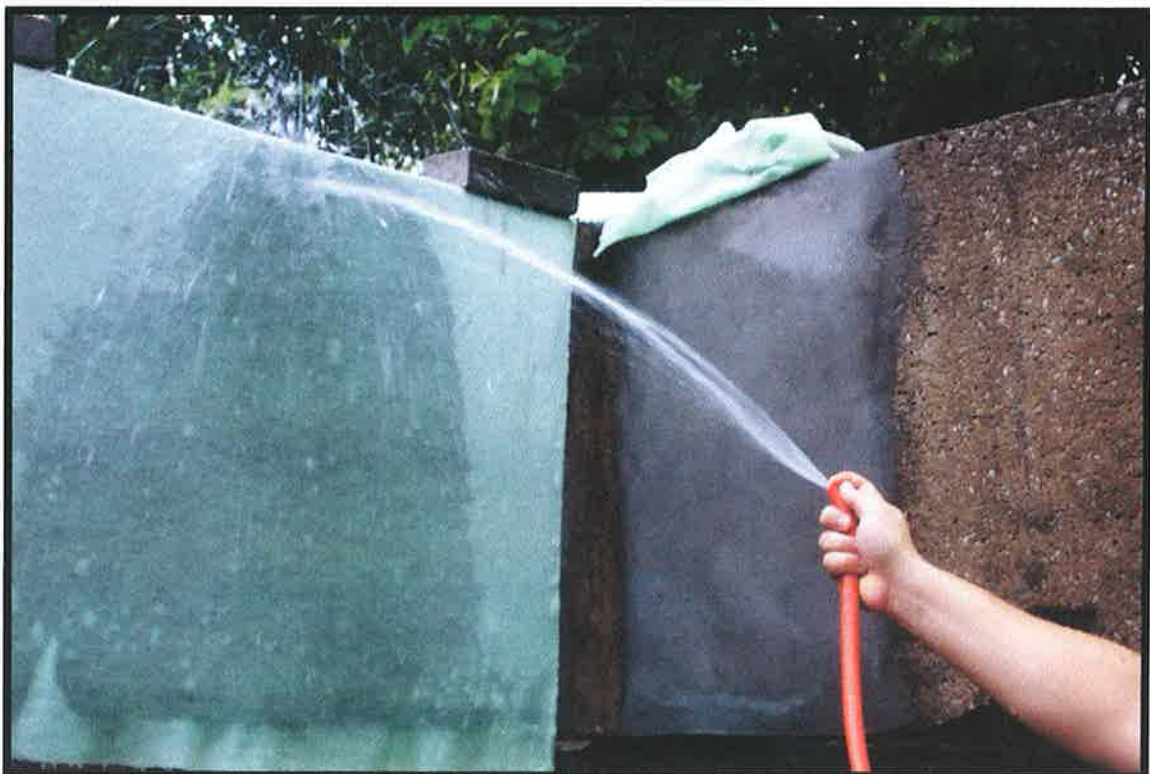
Figura A-11 – Cura úmida com auxílio de manta geotêxtil.
