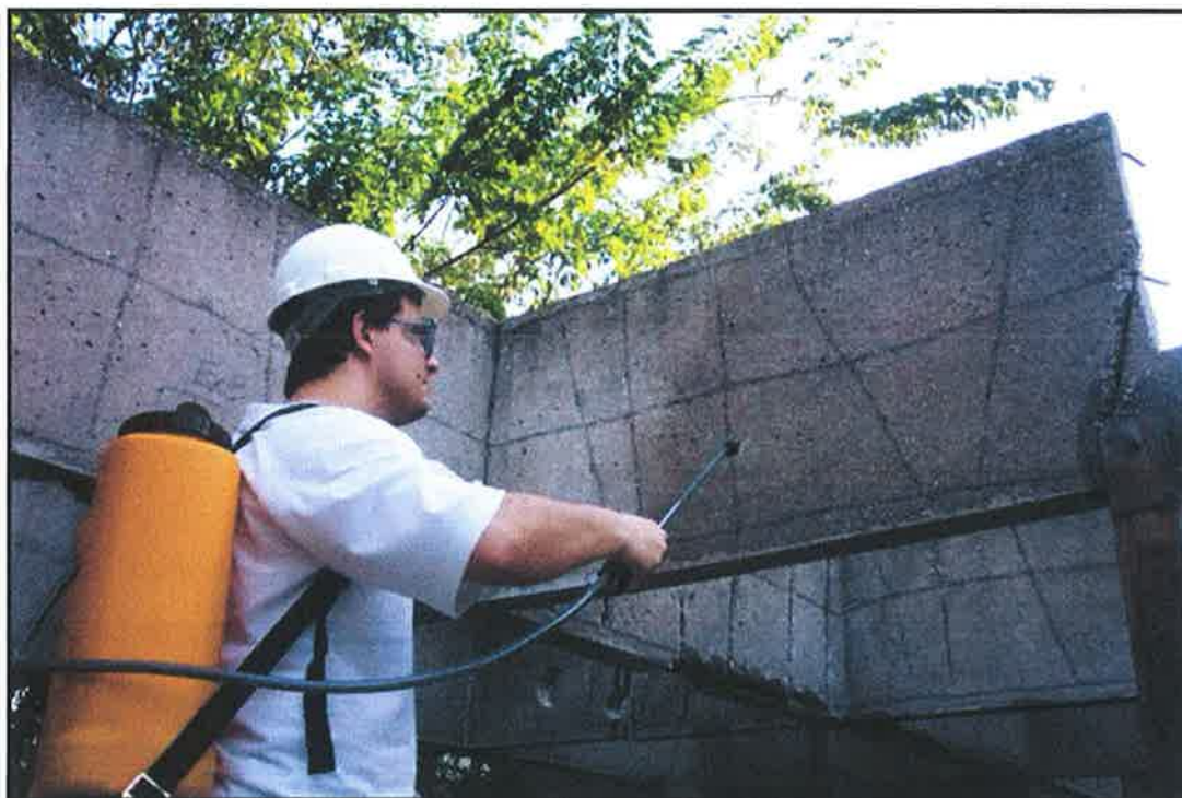
Figura 4-1 – Detalhe da aspersão de solução de cloretos (5%) no protótipo estrutural.
