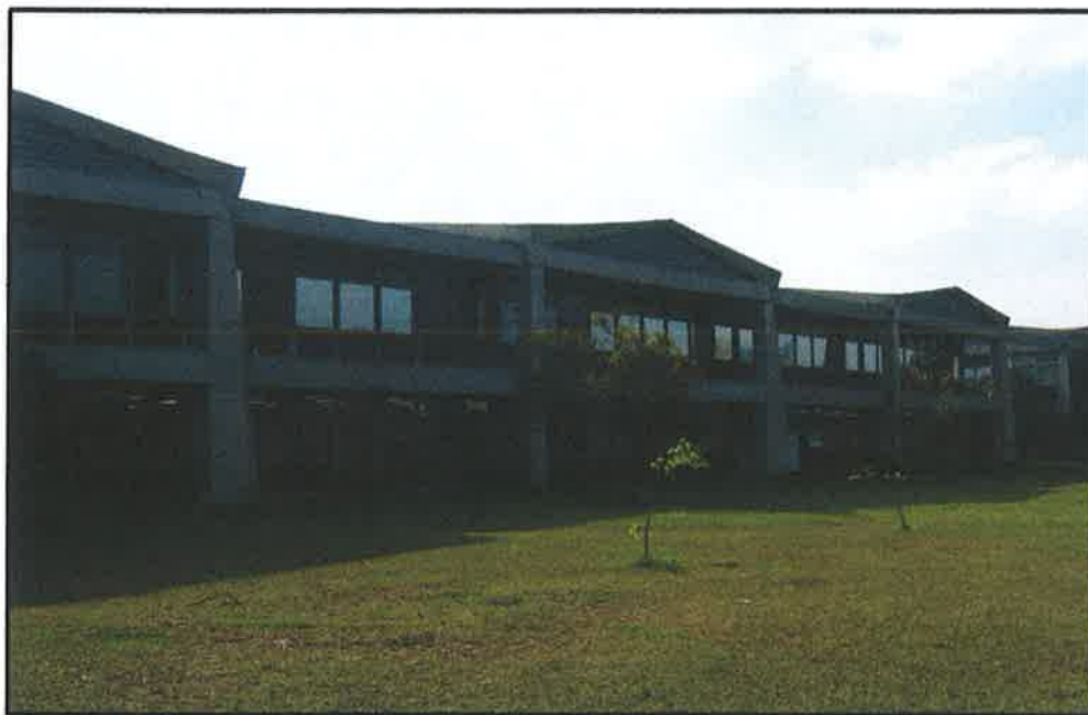
Figura 3-1 – Foto da fachada da edificação de onde foi retirada a grelha que constitui o protótipo estrutural.
