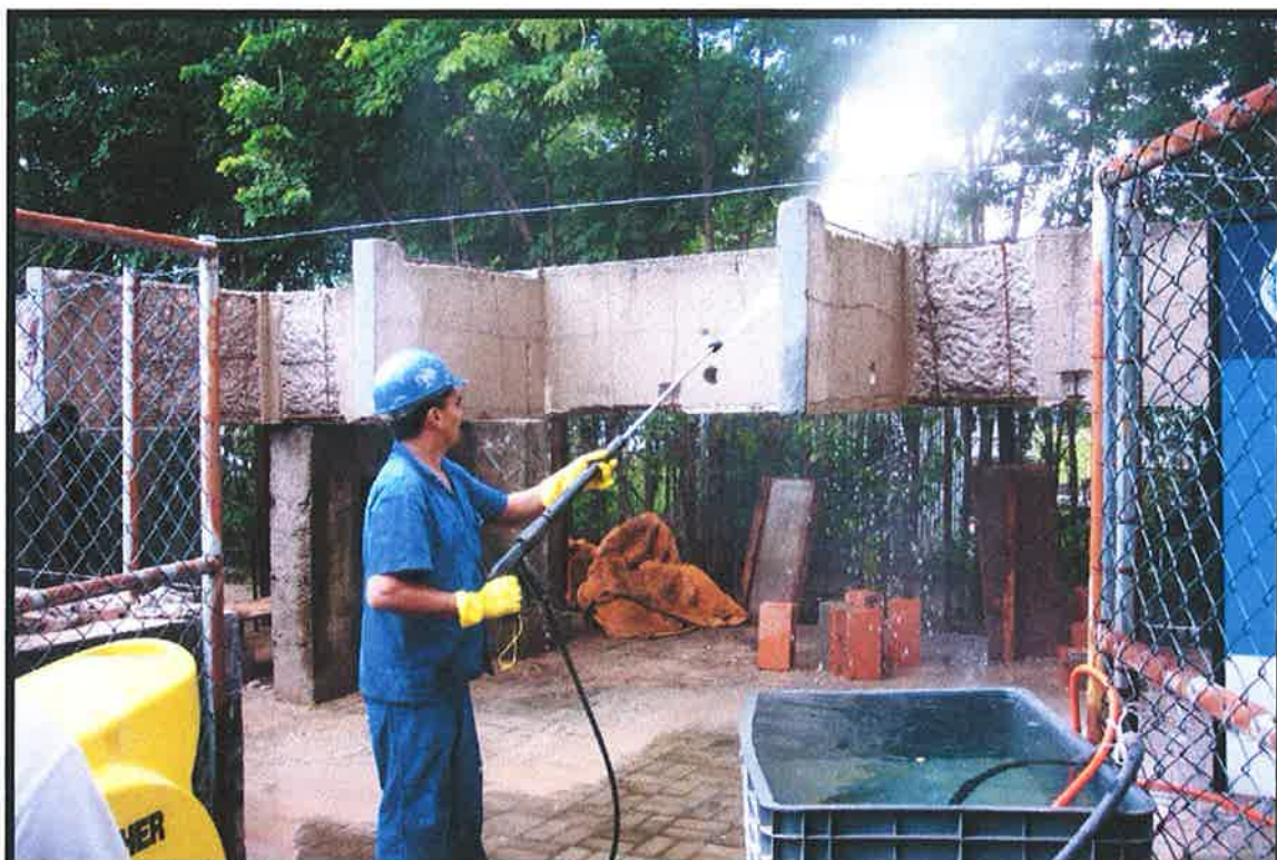
Figura A-8 – Lavagem da área com água a 80°C para a remoção dos cloretos.
