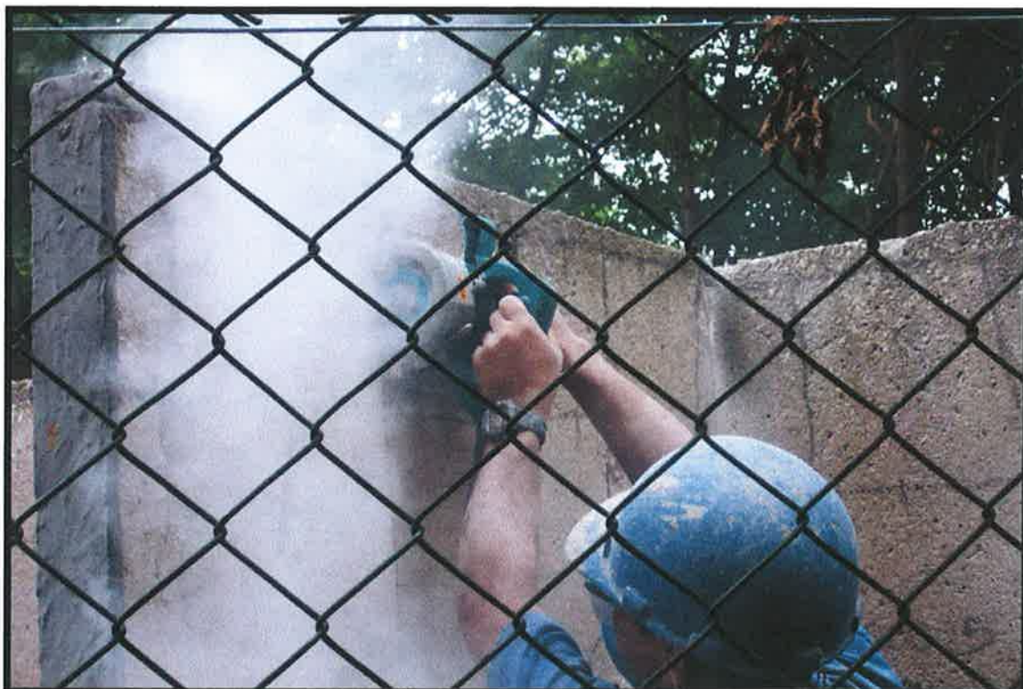
Figura A-4 – Limitação da área de reparo com disco de corte.
