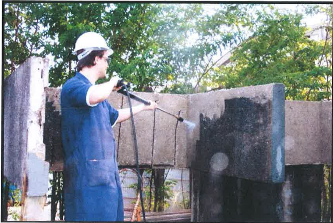
Figura A-2 – Detalhe da execução da limpeza do protótipo estrutural com jato d'água quente sob pressão para remoção de fuligem, mofo, concreto destacado etc, deforma a melhorar a visualização das áreas deterioradas.
