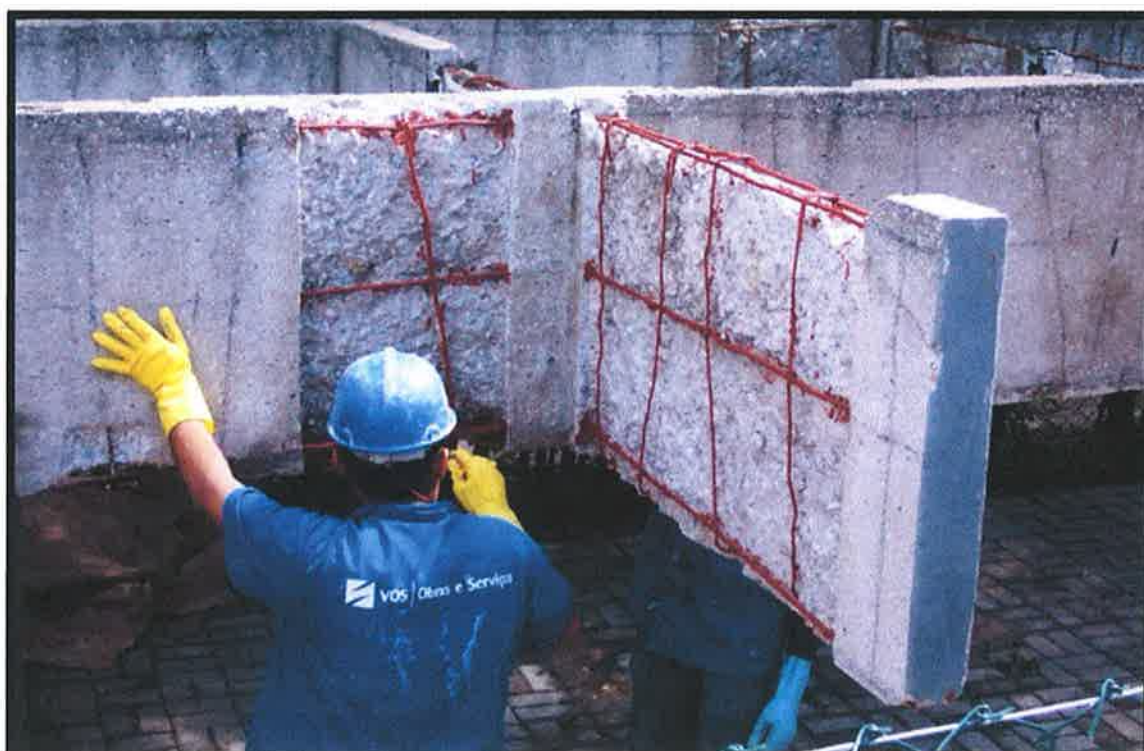
Figura A-9 – Aplicação dos sistemas de reparo constituídos por primers (quando fosse o caso).
