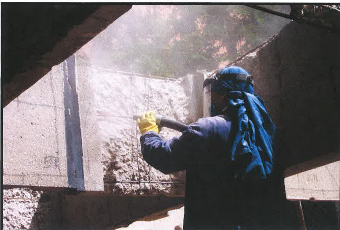
Figura A-7 – Limpeza das barras com jato de areia seca.
