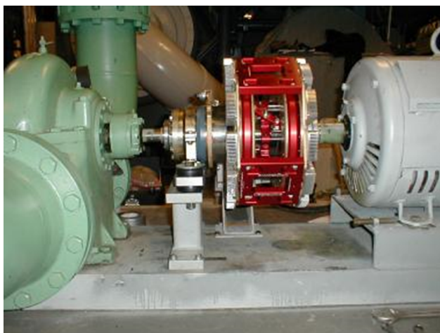
Figura 1.3 – Exemplo de aplicação do acoplamento magnético: bomba hidráulica [32]
