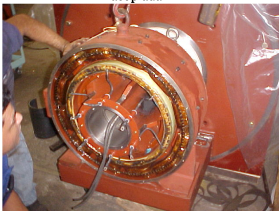
Figura 8 - Montagem da excitatriz em separado
