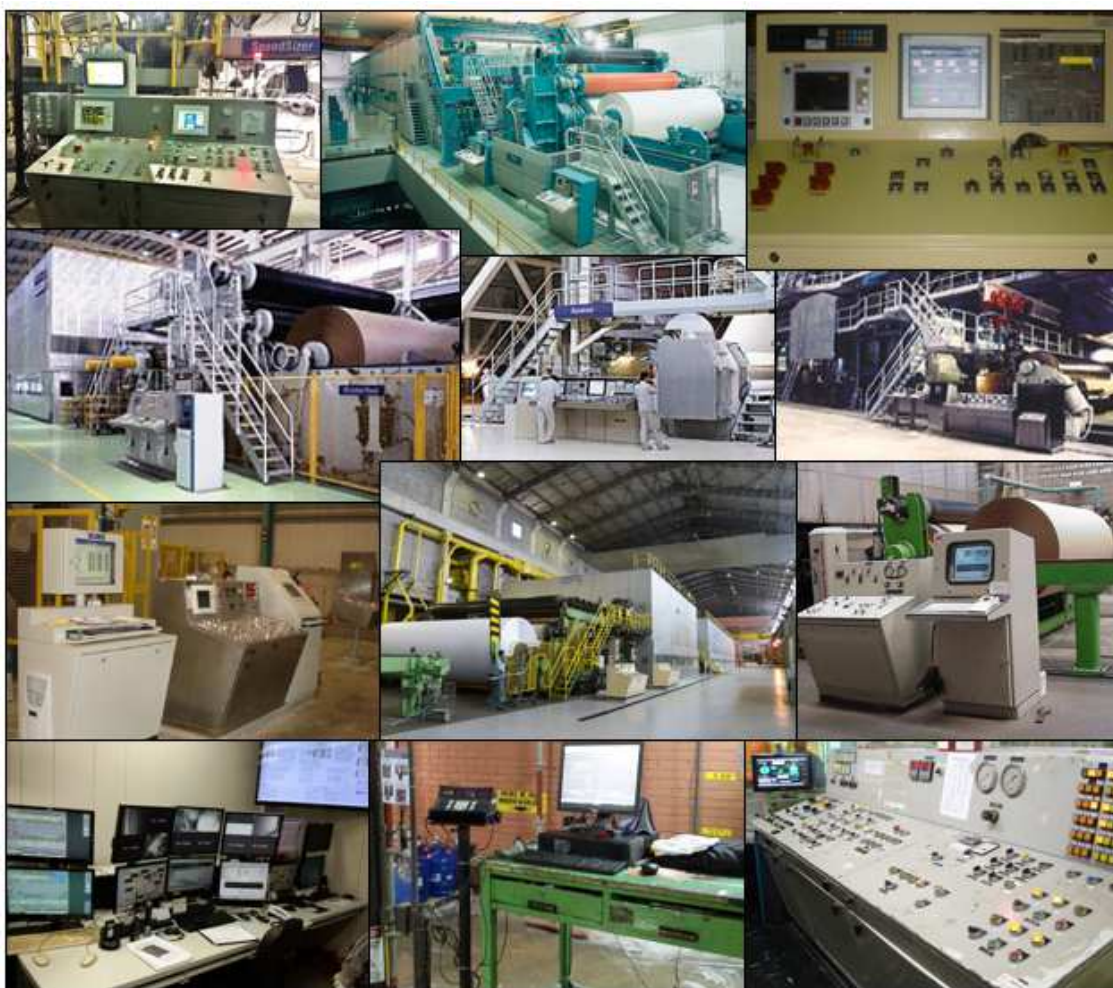
Figura 10 – Painel elétrico de operação com automação sem integração
