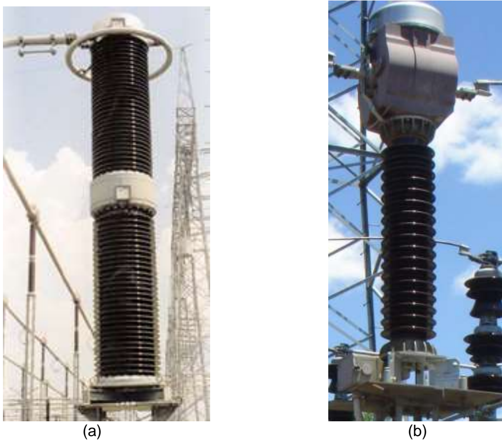
Figura 2 - Transformadores para instrumentos indutivos. (a) Transformador de tensão. (b) Transformador de corrente.
