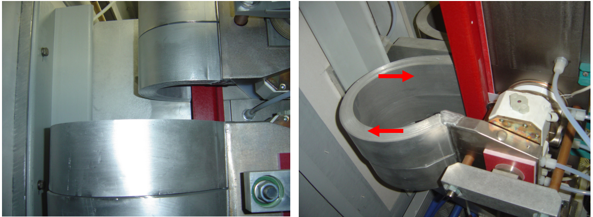
a) Detalhe da montagem
