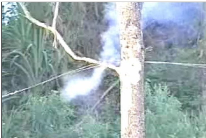
Figura 14 – Curto circuito fase terra – cabo sobre árvore
