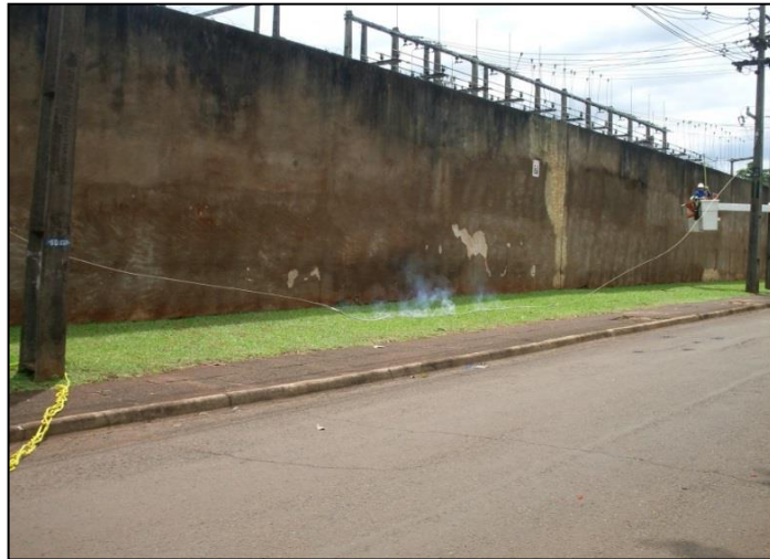
Figura 12 – Curto circuito fase terra – grama úmida
