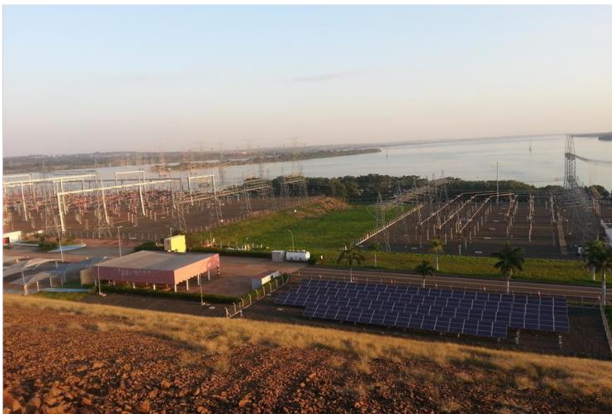
Figura 32 – Subsistema em solo da UFV-ILS.
