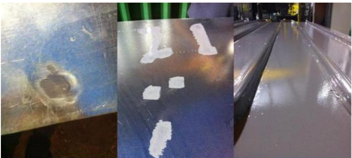
Figura 70 – Figuras representativas do polimento e aplicação de tinta anticorrosão.
