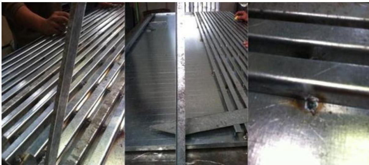
Figura 71 – Chapas finas cortadas, dobras e fixadas por ponteamto de solda de solda.
