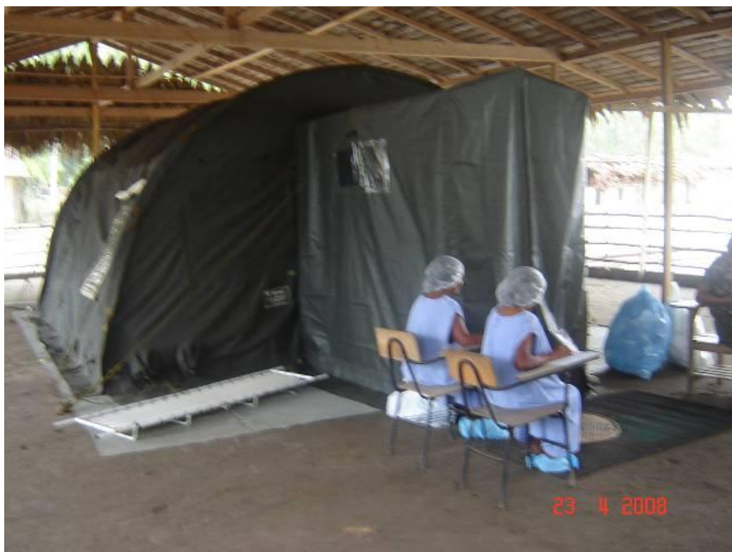
Figura 30 - Proteções contra incidência solar e material da barraca limitam a iluminação natural
