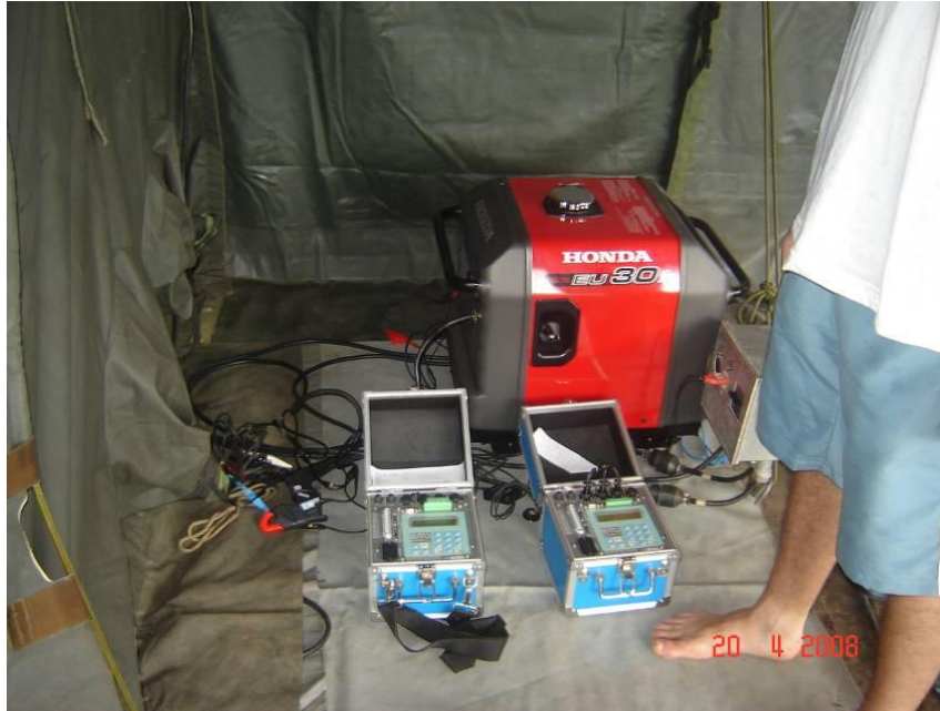
Figura 19 – Arranjo para medição do gerador 3
