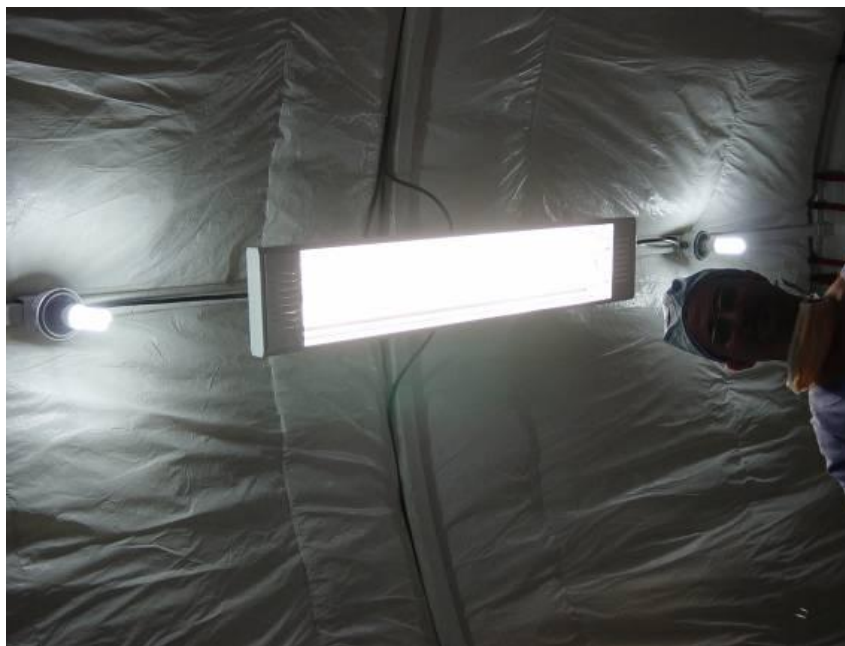
Figura 49 - Iluminação do Centro Cirúrgico trocada
