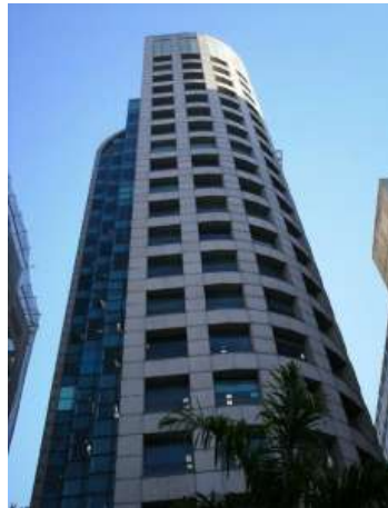
Figura 1 - Fotografia do Edifício Citi Center / Citibank
