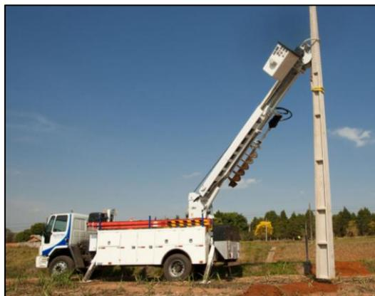
Figura 5 – *Digger derrick* implantando poste [12]
