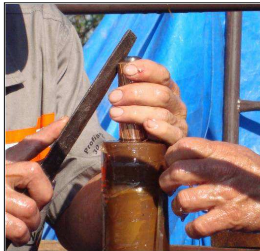
Figura 70 - Preparação da ponta do cabo.
