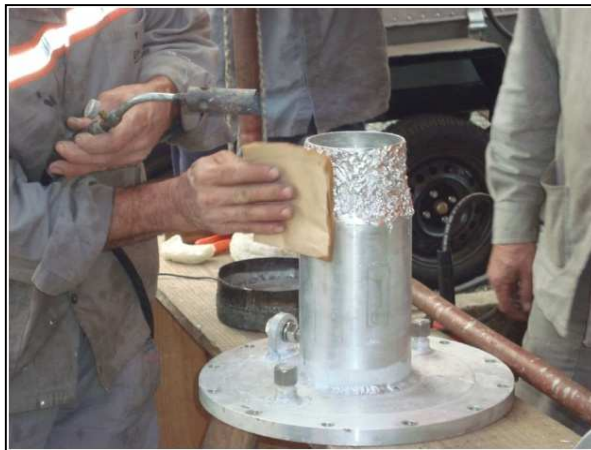
Figura 64 - Preparação de materiais para montagem do terminal.
