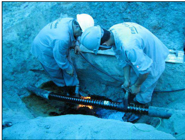
Figura 52 – Preparação do cabo para congelamento.
