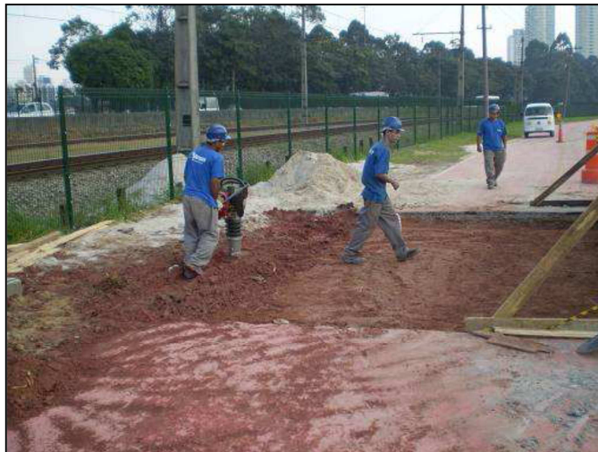
Figura 57 – Compactação de terra em vala.
