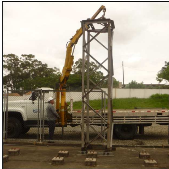
Figura 62 - Fixação de torre metálica.
