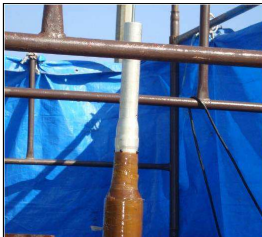
Figura 71 - Conector fixado no condutor de cobre
