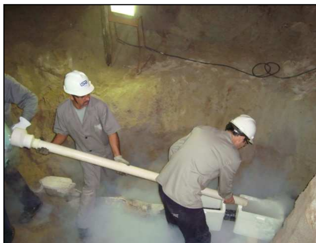
Figura 53 – Colocação de nitrogênio líquido na câmara de congelamento.
