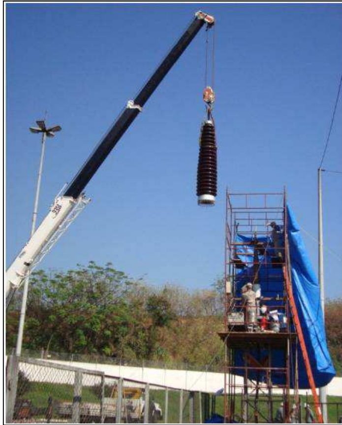
Figura 74 - Porcelana sendo levada até a base do terminal.
