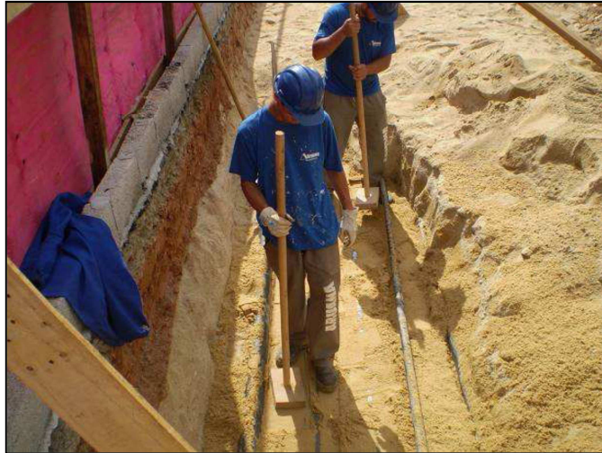
Figura 56 – Compactação de areia média lavada em vala.
