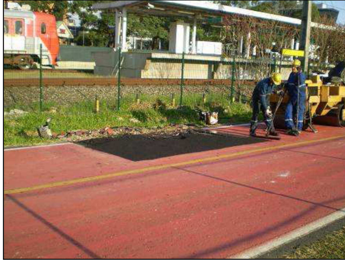
Figura 59 – Reconstituição do asfalto.
