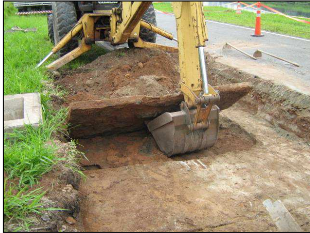
Figura 51 – Escavação para acesso ao cabo subterrâneo.
