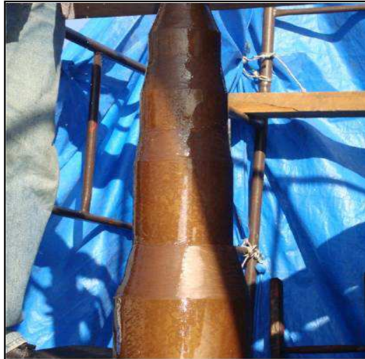
Figura 69 - Papéis acima do cone defletor de campo sendo preparados.
