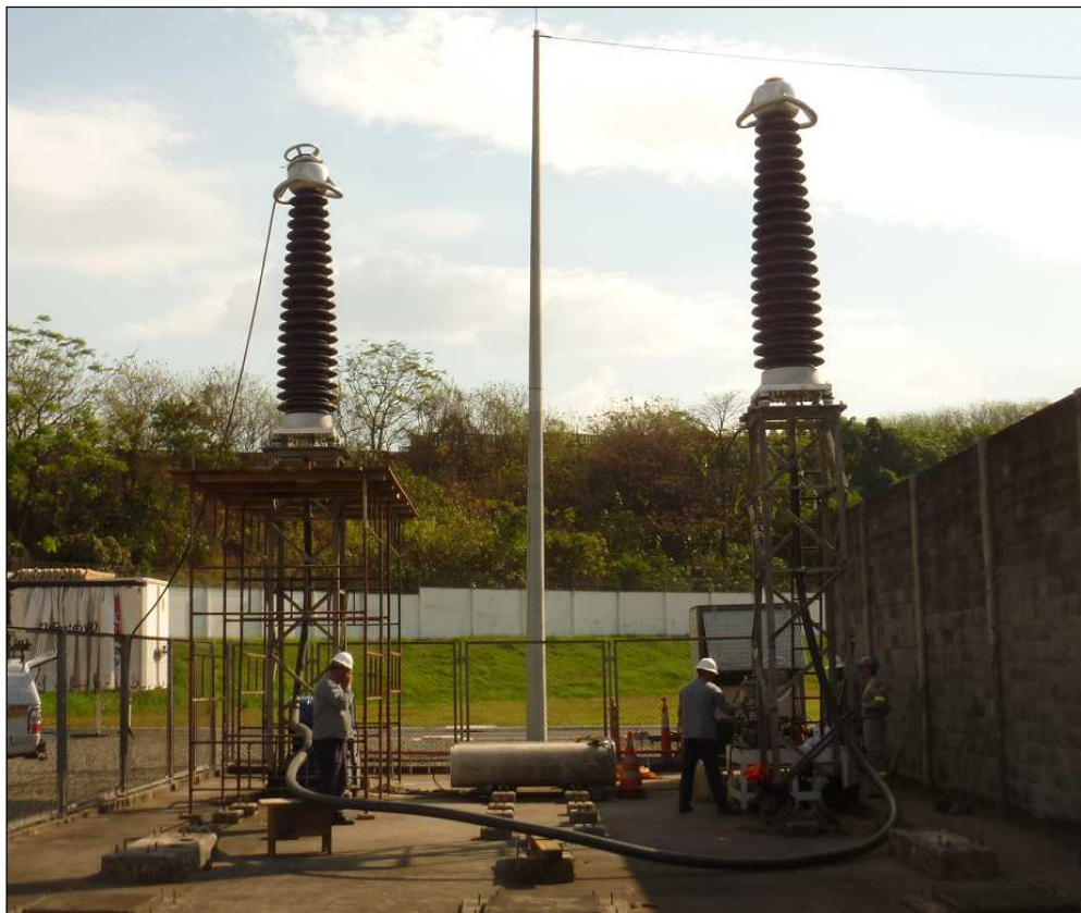
Figura 34 - Protótipo contendo 30 m de cabo OF e 2 terminais de 345 kV.
