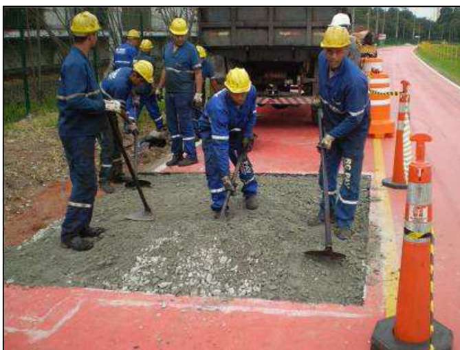
Figura 58 – Colocação de bica corrida em vala.
