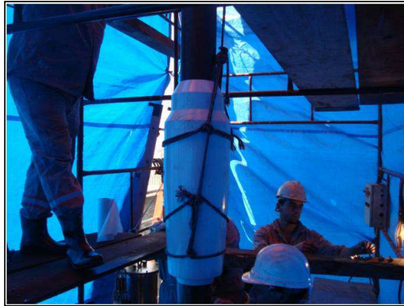
Figura 67 - Posicionamento do cone defletor de campo.
