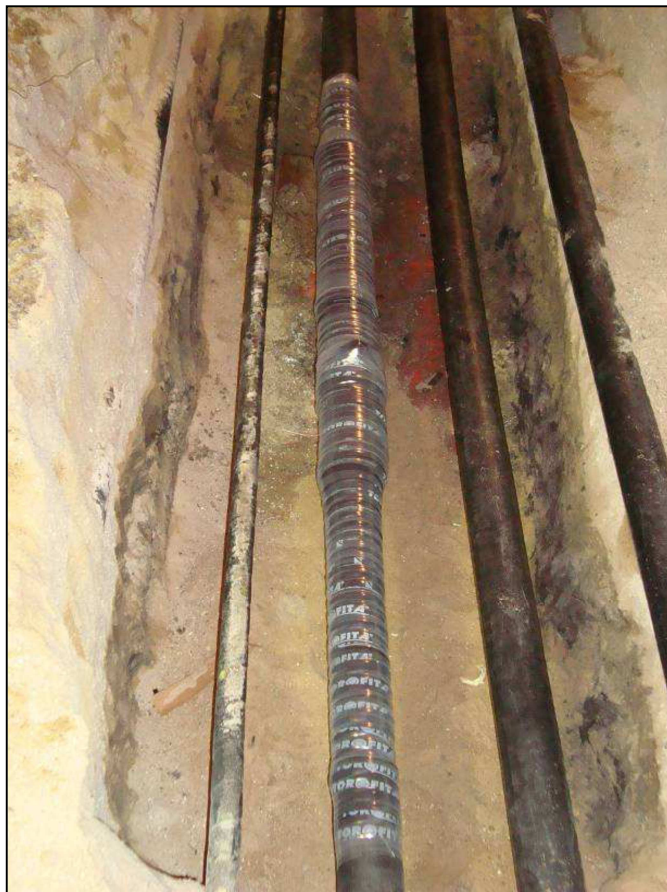
Figura 55 - Aplicação de fitas após o congelamento.
