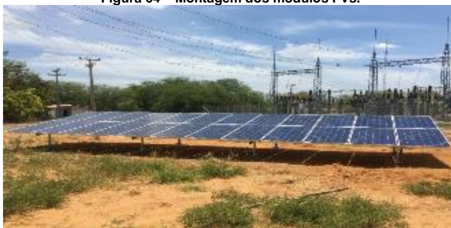
Figura 64 – Montagem dos módulos FVs.
