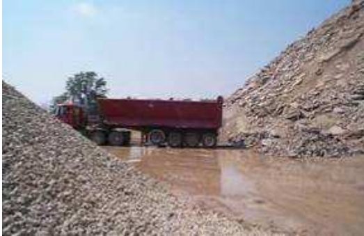
Figura 1.1 - Chegada de concreto demolido de pavimentos ao estoque
