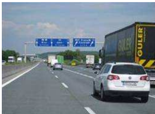
Figura 1.53 - Pavimento de concreto reciclado na rodovia Viena-Salzburg após 14 anos de sua construção (março de 2008)
