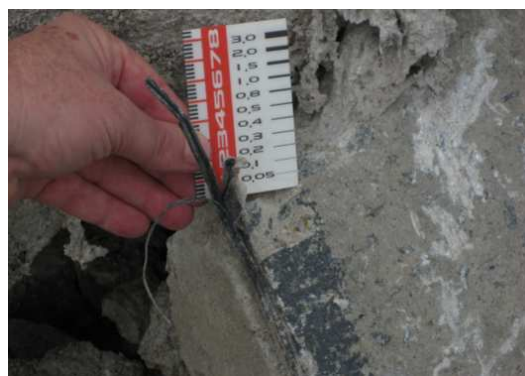
Figura 2.4 - Selante das juntas
