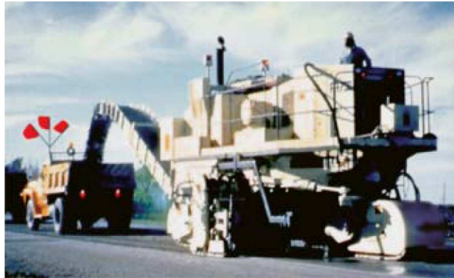
Figura 1.5 - Remoção de superfície de asfalto utilizando uma fresadora (NHI, 1998 apud ACPA, 2009)
