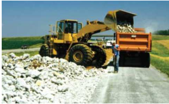
Figura 1.13 - Remoção e transporte do pavimento fragmentado com o uso de uma pá-carregadeira e um caminhão caçamba (ACPA, 2009)
