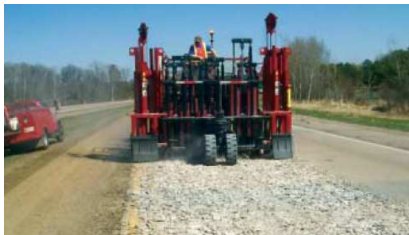
Figura 1.8 - Equipamento de martelo hidráulico multi cabeças para quebra de pavimento (ACPA, 2009)
