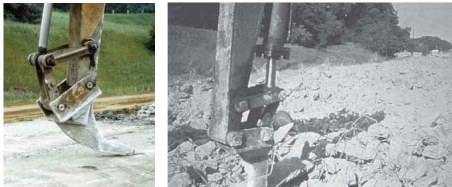
Figura 1.12 - Cortador de lança frontal utilizado para soltar os pedaços de concreto (ACPA, 2009)
