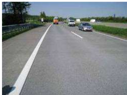
Figura 1.54 - Pavimento de concreto reciclado na rodovia Viena-Salzburg após 14 anos de sua construção (março de 2008)
