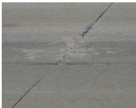
Figura 2.1 - Pavimento de concreto do Rodoanel
