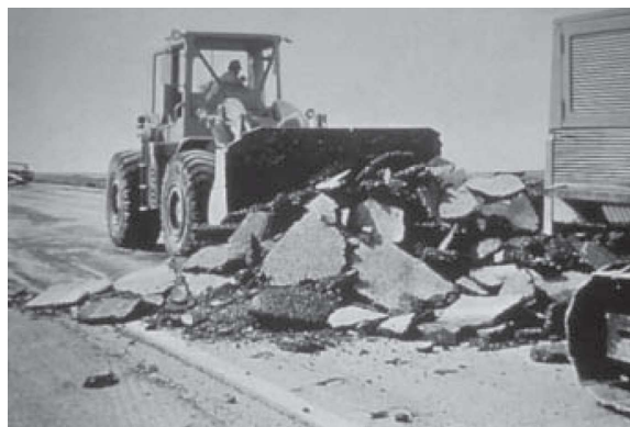
Figura 1.6 - Remoção de superfície de asfalto utilizando fresadora e pá carregadeira (NHI, 1998 apud ACPA, 2009)
