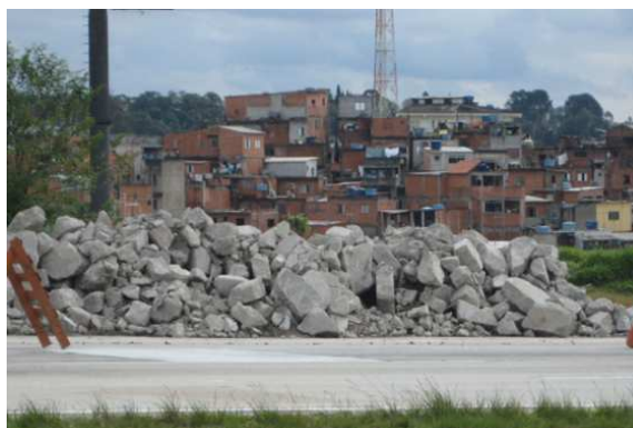
Figura 2.2 - Placas de concreto retiradas do Rodoanel
