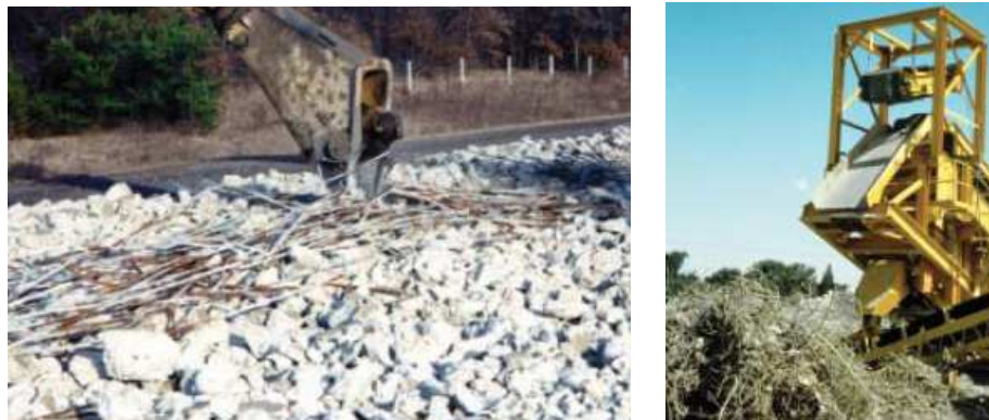
Figura 1.14 - Remoção da armadura de aço em campo ou após a britagem (ACPA, 2009)
