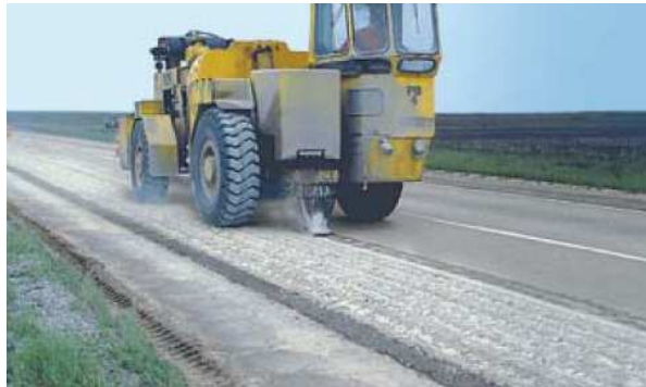
Figura 1.10 - Equipamento de viga vibratória para a quebra de pavimento (ACPA, 2009)
